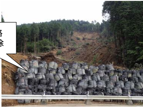
崩壊土量10,000m 3 以上の早期解除箇所の例
