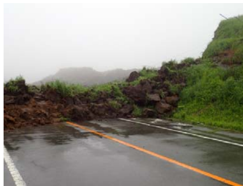
緩斜面の崩壊による道路閉塞状況 (幅50m, 斜面長100m, 傾斜15°)
