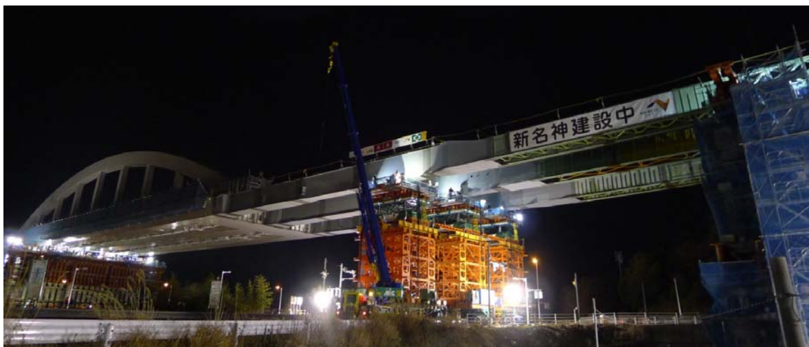
[架設時写真：「2016-3 橋梁と基礎」より]
