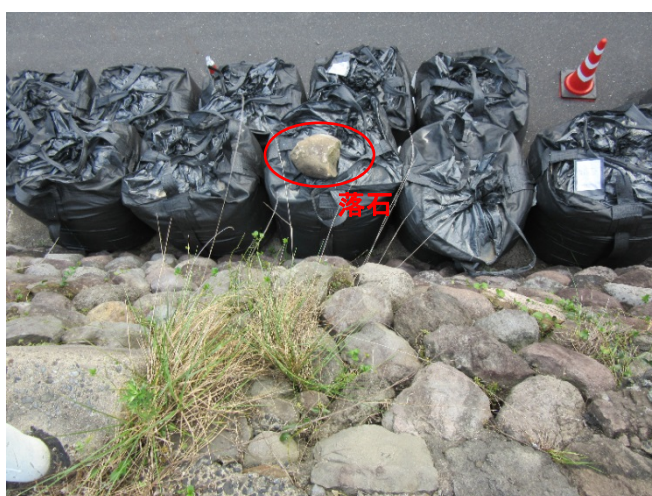
写真 2.26 大型土嚢の上部にみられる落石
