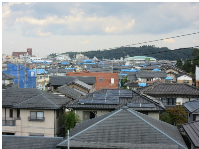
写真2.3 極楽寺より北方の屋根瓦の状況
