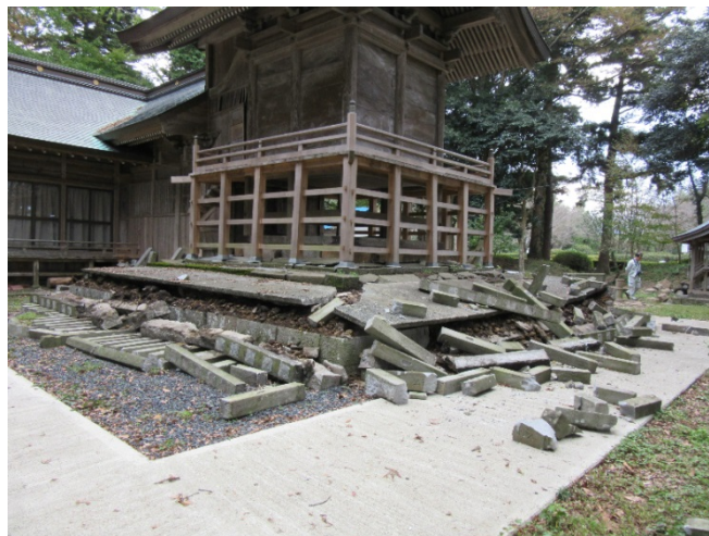
写真2.11 玉垣の倒壊
