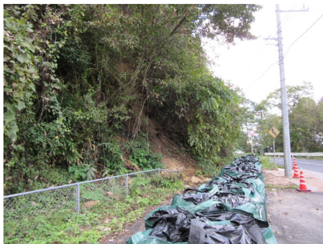
写真 2.22 ②部に見られる自然斜面の表層崩壊
