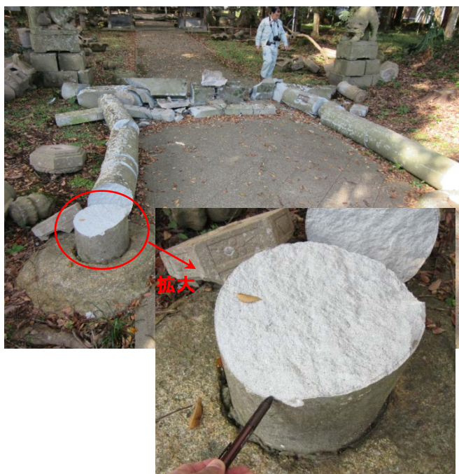
写真2.10 石造の鳥居の倒壊
