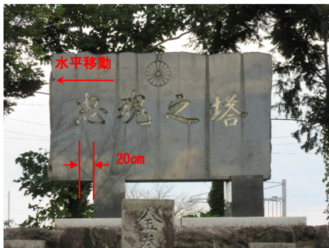
写真2.13 南西方向へ水平移動した石碑
