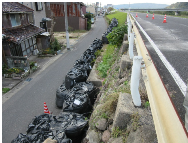
写真 2.25 ガードレール基礎の移動
