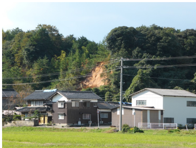
写真4.1 北栄町米里の崩壊地遠景
