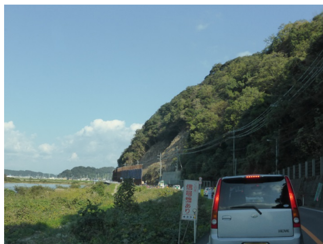
写真2.1 落石発生箇所遠景
