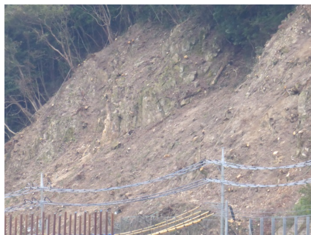
写真2.2 落石発生箇所の斜面状況
