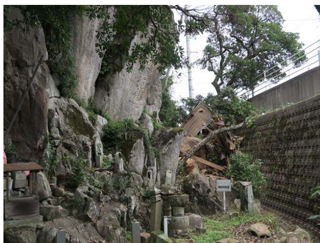
写真2.12 田内城跡（落石、釈迦堂の崩壊）
