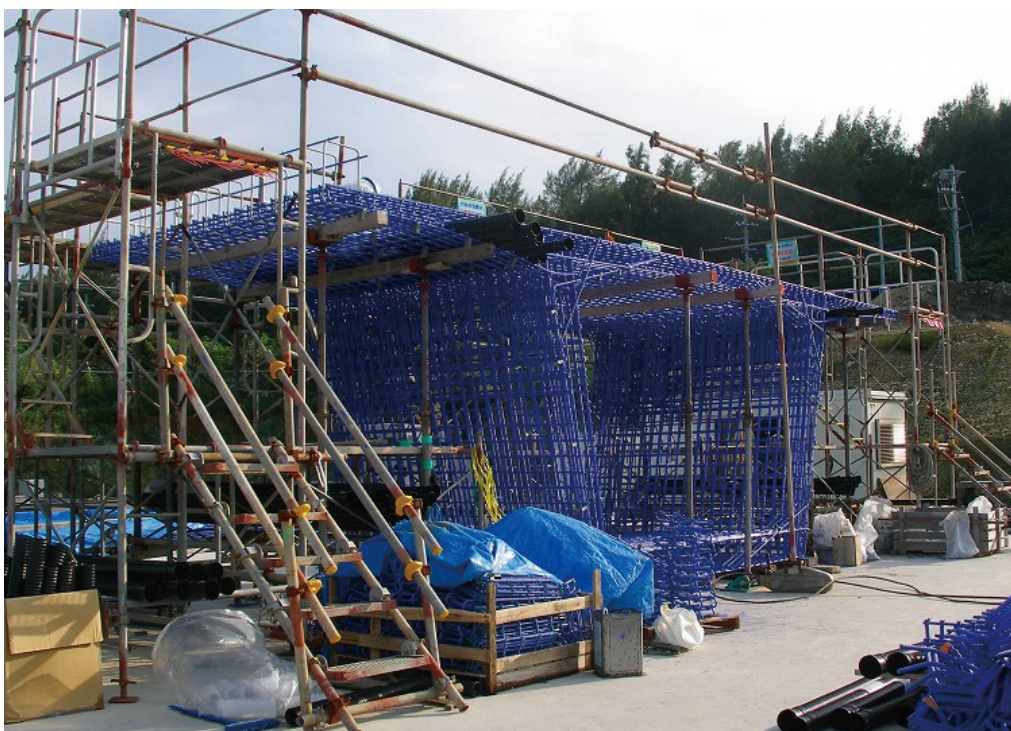
桁の鉄筋の組み立ての状況（2008年11月）。 これが1ブロックの桁部材になる。
