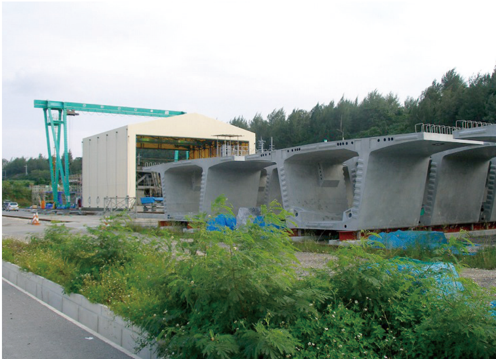
桁の製作ヤードと完成した桁部材
