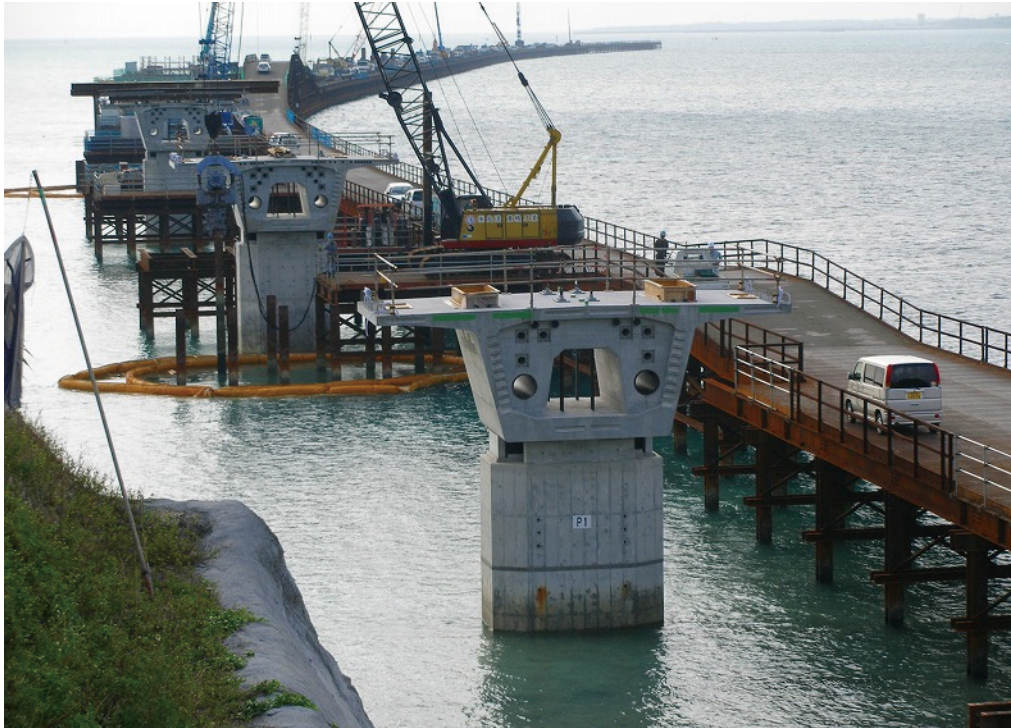
桁の架設開始（宮古島側から、2008年11月）
