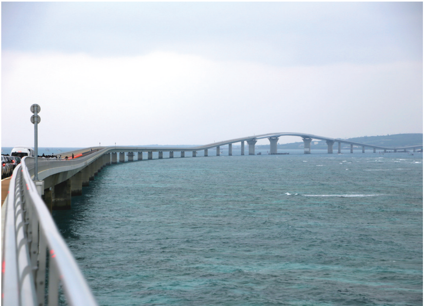
宮古島側から伊良部島側を望む （渡り初めの風景）
