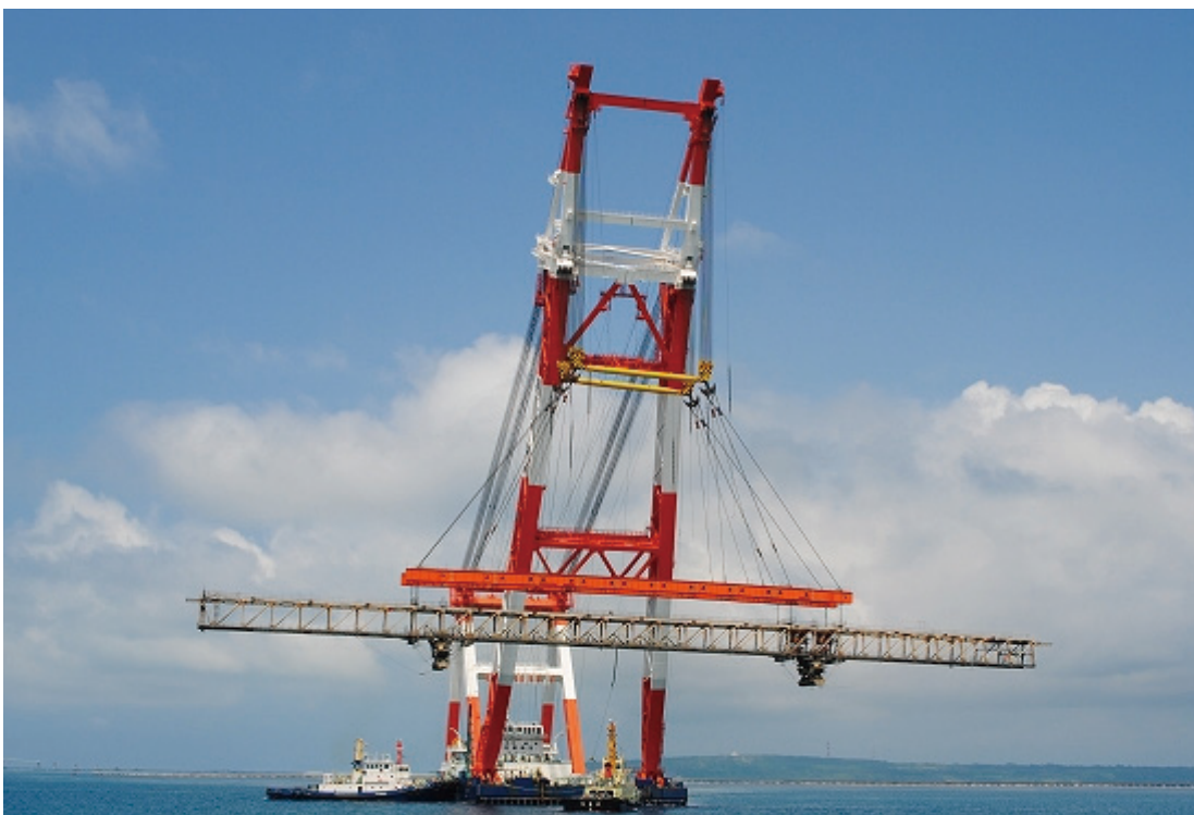
架設桁移設の状況(2012年5月)
