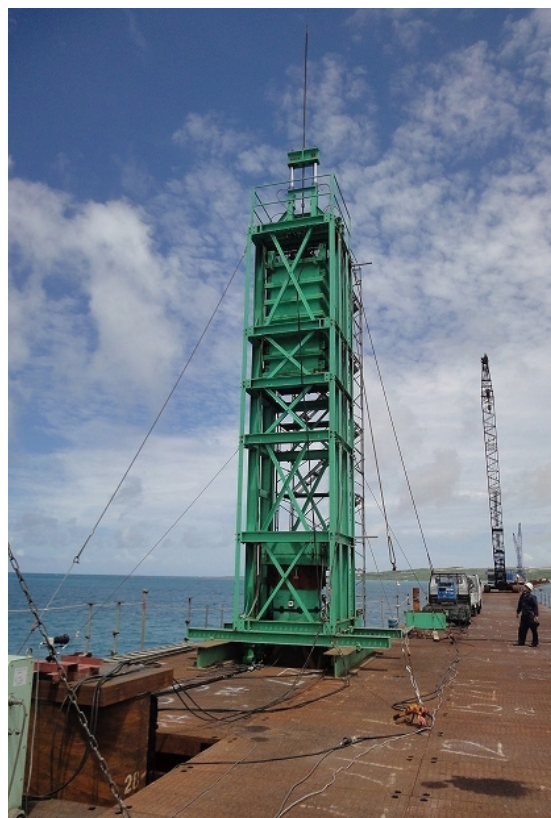
急速載荷試験の様子(2010年7月)
