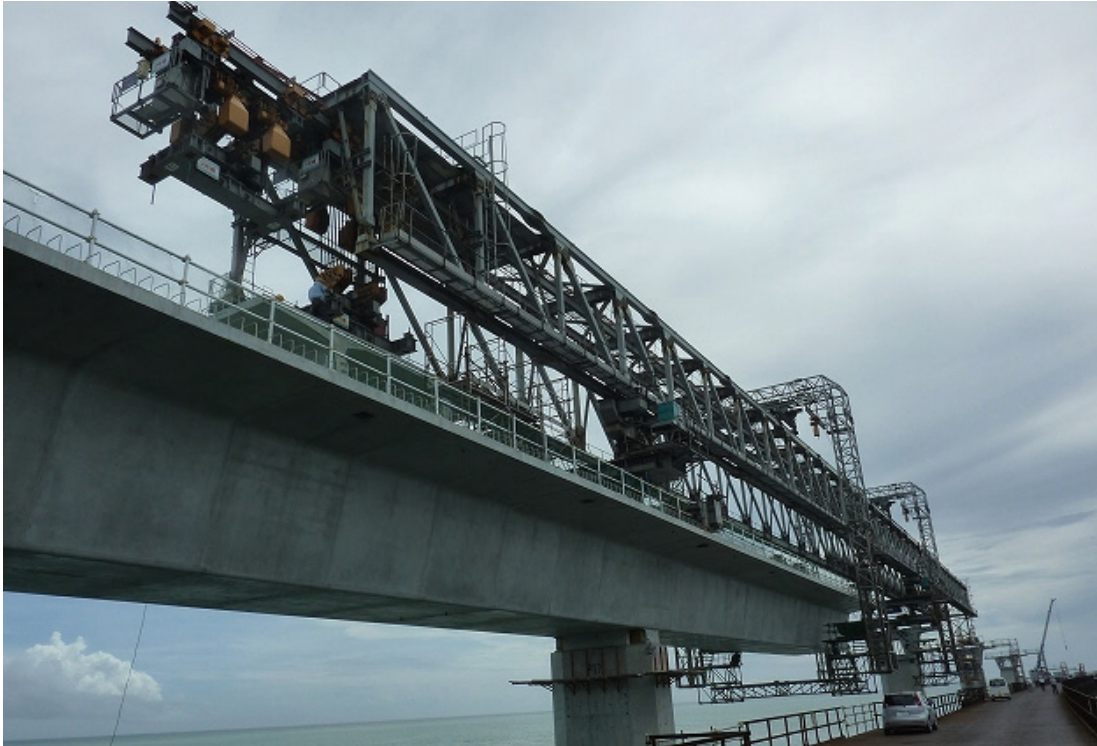
架設桁による桁の架設。 先の写真で示した1ブロックの桁部材を締め付け一連の橋桁にしていく。 工事用栈橋から(2010年7月)。
