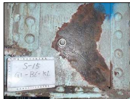
ストップホール施工の状況
