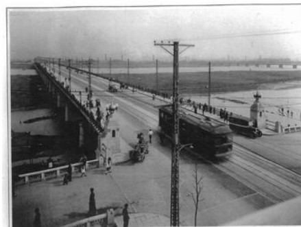
架設当時(大正 15 年)の淀川大橋
