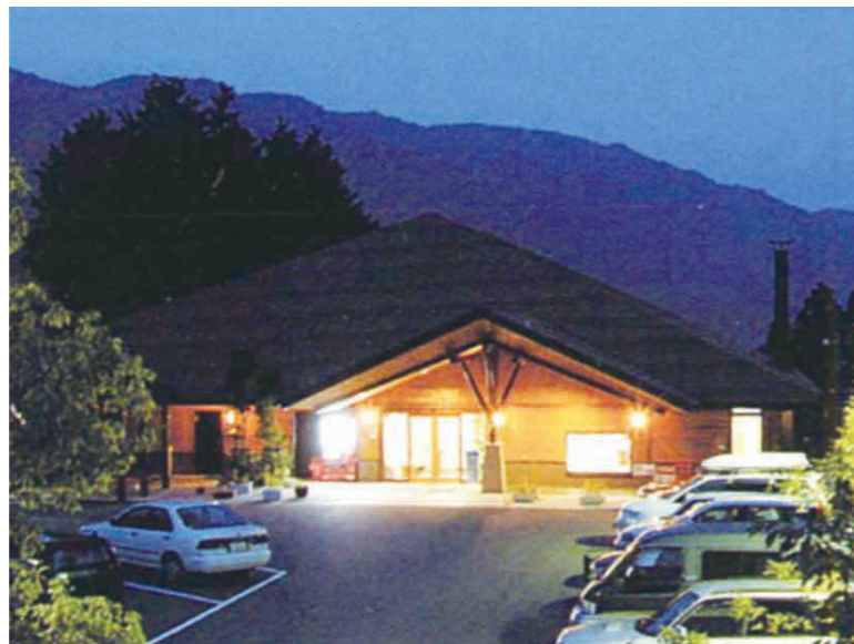
とがやま温泉施設整備PFI事業（兵庫県）
