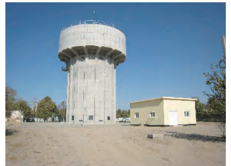
ハトロン州ビアンジ県給水改善計画（タジキスタン）
