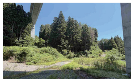
▲橋梁点検現場の環境事例
