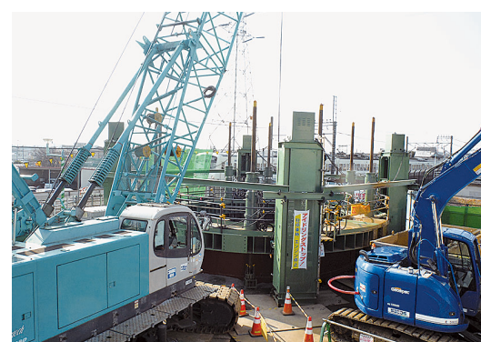
アーバンリング工法による狭い作業ヤードでの施工状況
