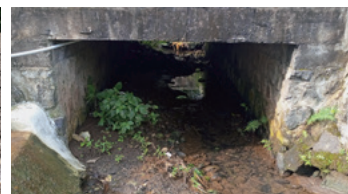
▲狭隘で水深の浅い溝橋
