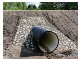
▲小口径で通水のない管路
