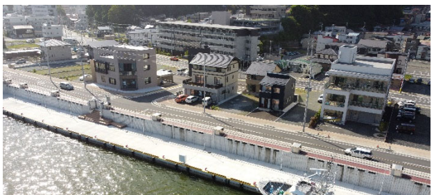
海側から魚町地区を望む
