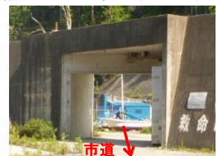
写真2 市道部の既設陸閘
