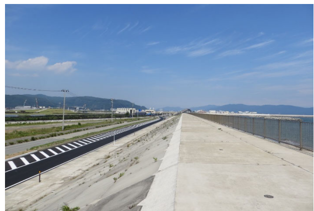
写真2 東浜防潮堤(2021年7月撮影)
