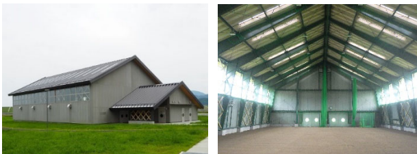
写真4 完成した屋内練習場
