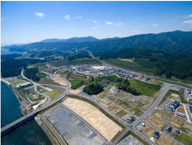
写真 2 整備された高台部(2021年7月)
