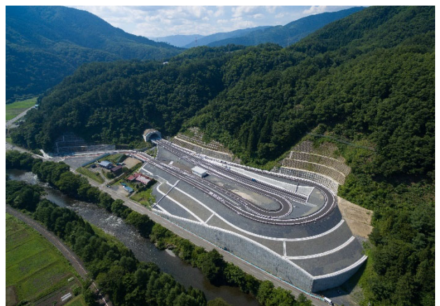
写真7 上川井出入口
