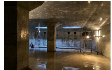
写真5 雨水貯留槽
