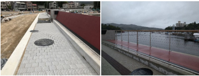
ゲートが起立している状況 ゲートが格納されている状況
