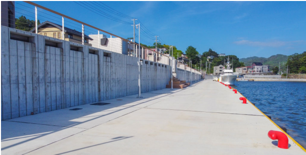
写真2 魚町地区防潮堤 (2021. 8. 3 撮影)
