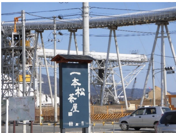
写真1 復興工事に使用したベルトコンベア (2015年3月)
