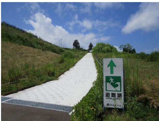
写真8 完成した避難路(2) (2021年7月)
