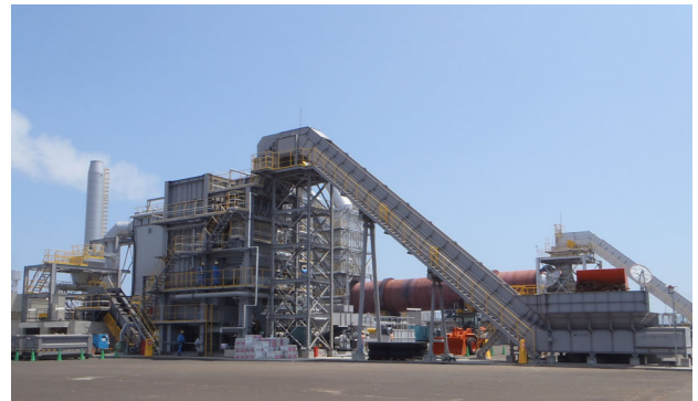
写真2 仮設焼却炉(手前:ストカ炉,奥:キルン炉)
