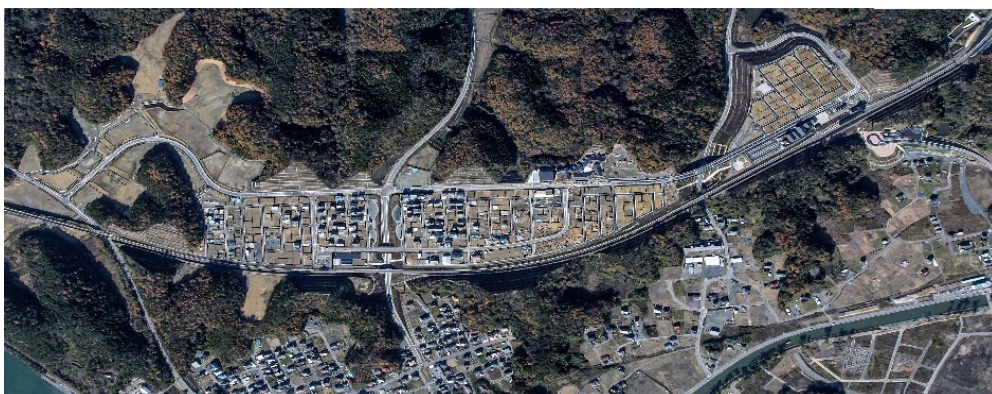
写真1 高台移転地の完成時全体写真 (2016.11.13 撮影/大成建設JV撮影)
