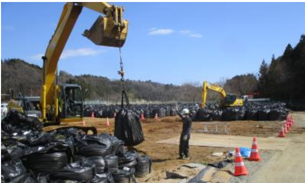
写真1 仮置場の状況
