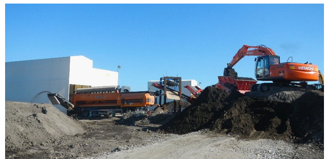
写真3 土壌の改質・選別作業状況
