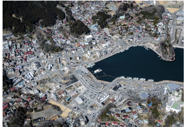
2015年3月26日撮影：堅牢建物は残存 災害公営住宅関連街区の盛土造成工事中
