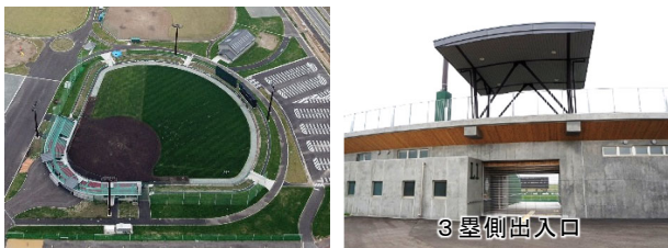
写真3 完成した第一野球場
