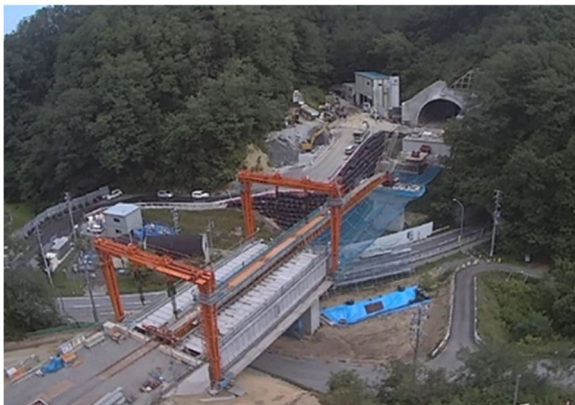
写真2 施工状況写真（小山田こ道橋）
