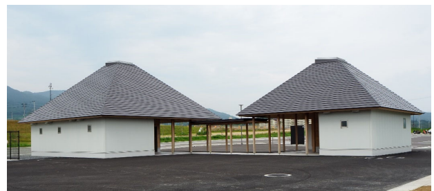
写真7 完成した公衆便所（100㎡タイプ）
