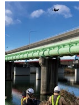
ドローンによる点検
