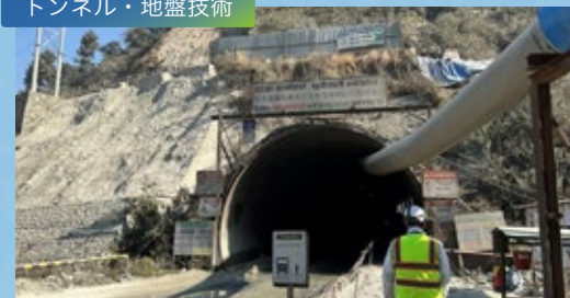
ナグドゥンガ・トンネル設計・施工監理(ネパール国)
