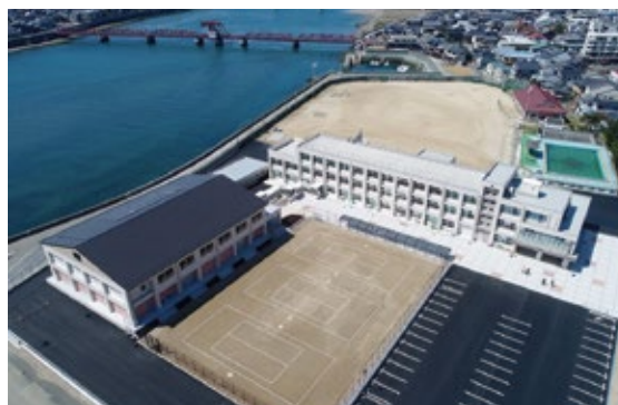
大洲市立長浜中学校(愛媛県)
