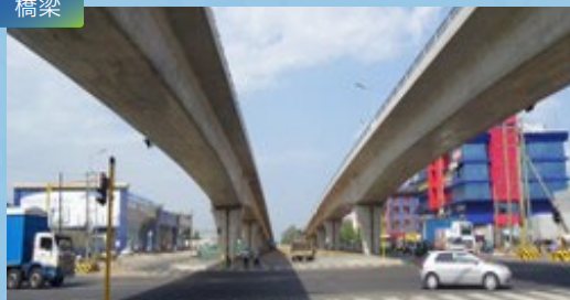
ダルエスサラーム市街地と空港を結ぶニエレレ道路の立体交差 (タンザニア国)
