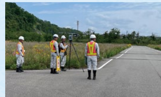
町道災害復旧のための測量業務(石川県)
