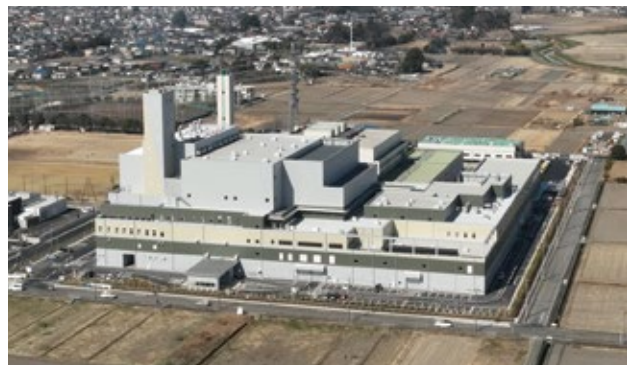
見沼環境センター(ごみ焼却施設・リサイクル施設) (埼玉県)
