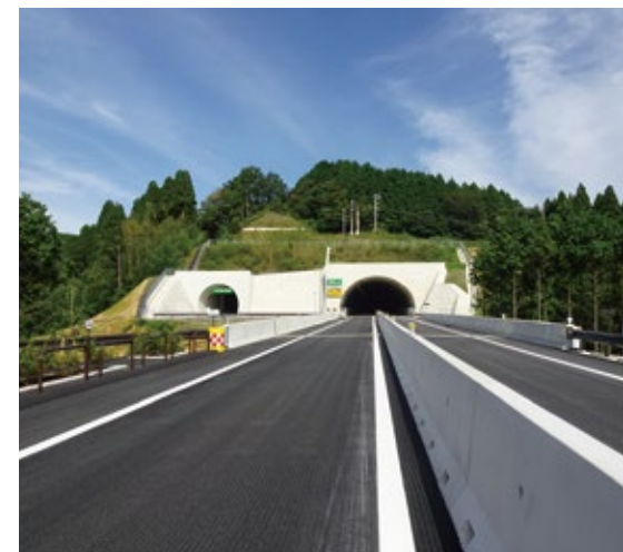
二重峠トンネル(熊本県)
