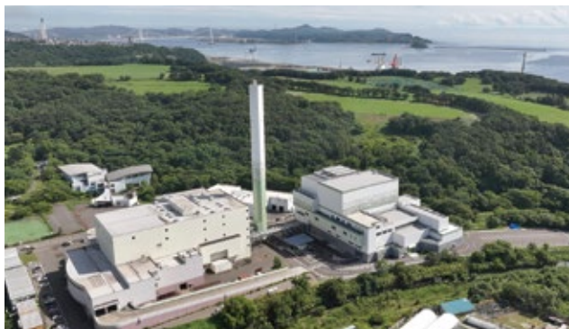
西いぶりエコファクトリー(ごみ焼却施設) (北海道)
