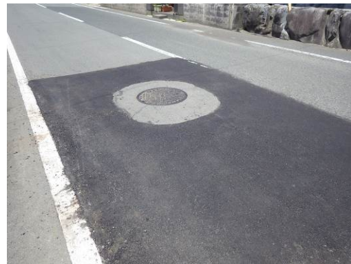
写真 7.2.13 立坑浮上(復旧済み)
