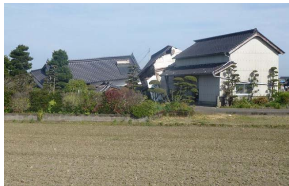
写真 8.1.7 嘉島町鯉での被害(4/16)
