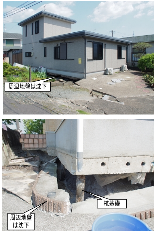
写真 3.2.6 杭基礎のある住宅 (秋津町)
