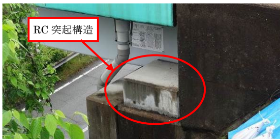
写真 4.1.5 橋台状況(RC 突起有り)
