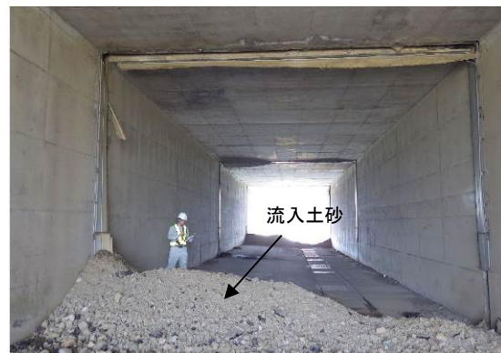
(a) カルバート内部
