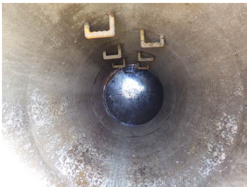
写真 7.2.6 マンホール内部
