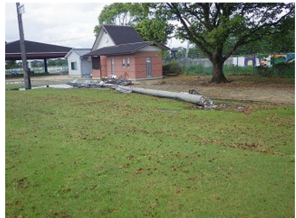
写真 8.3.1 照明柱の倒壊
