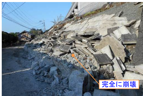
写真 4.3.12 ブロック積擁壁の崩壊
