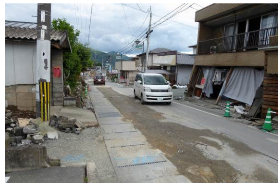
写真 9.1.8 市街地幹線道路 (幅員 6.5m)
