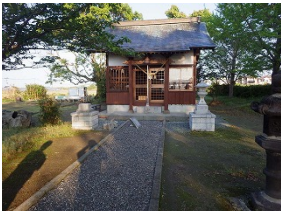
写真 8.2.10 燈籠の倒壊 (写真左)
