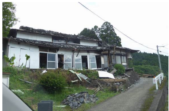
写真 9.1.4 西原村の建物被害
