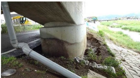
写真 4.1.11 橋脚状況(柱部には損傷無し)
