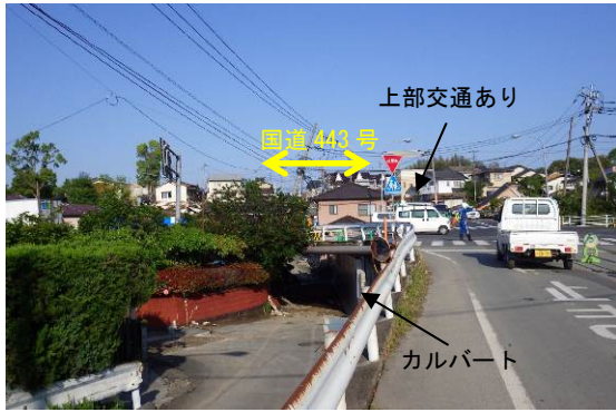
(a) 全景 (東側坑口部)
