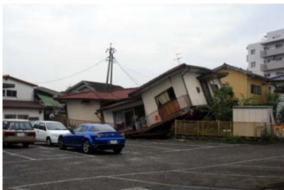
写真 8.1.6 沼山津での被害状況(4/25)
