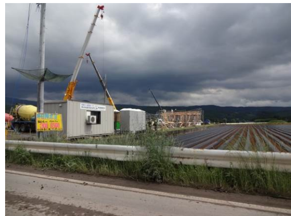
写真 9.3.1 応急仮設住宅の建設状況 (西原村)
