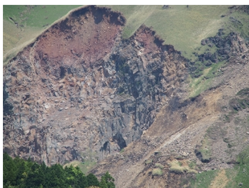
写真 10.3.3 阿蘇市車帰における 外輪山崩壊(2)
