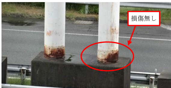
写真 4.1.4 ロックンギピア状況(異常無し)
