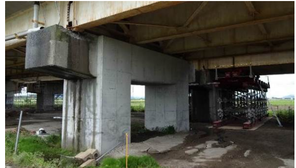
写真 4.1.19 橋脚巻立て補強部(損傷無し)
