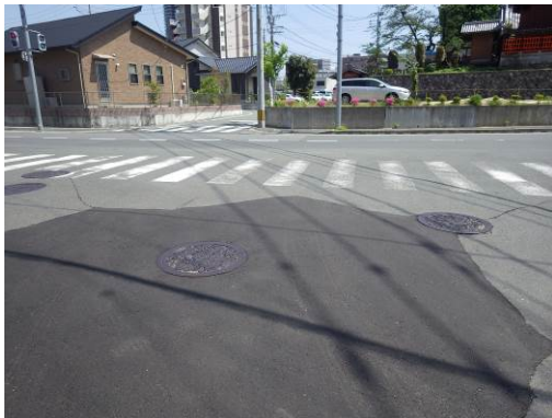
写真 7.2.11 舗装の復旧跡
