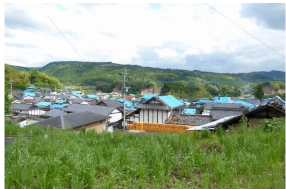
写真 9.1.3 西原村の建物被害
