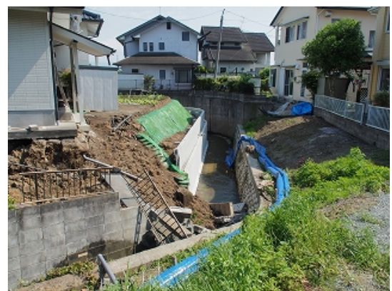
写真 5.4.3 下流側水路擁壁
