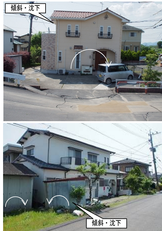
写真 3.2.4 住宅の傾斜・沈下 (秋津町)
