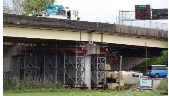
写真 4.1.20 上り線応急復旧作業状況
