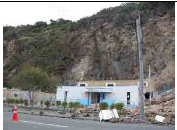
崩壊箇所の周辺斜面。落石程度は認められるが、斜面の不安定化傾向はない。
