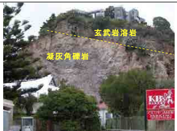
地質状況。最上部に玄武溶岩が分布しその下に凝灰角礫岩がほぼ道路面まで層厚 30m 程度と厚く分布している。
