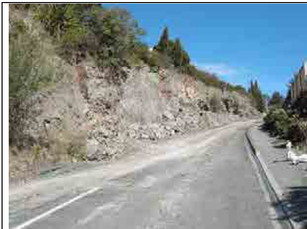
切土のり面の崩壊
