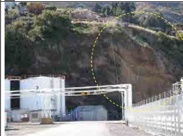
29 写真 26 の被災箇所を斜面下方から望む。80度程度の急峻斜面で、幅 30m 程度に渡って表層崩壊が発生している。
