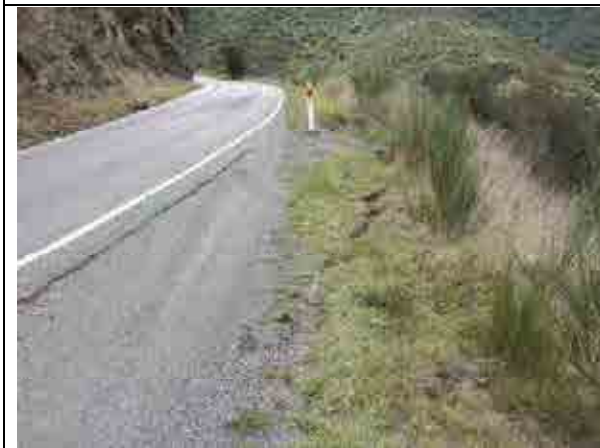
5 表層のすべり。構造物はなく地すべり的な変状である。表層は盛土の可能性はある。
