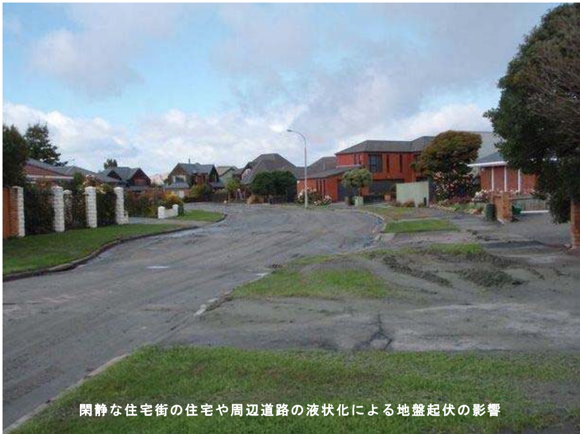
図-8.3.5 住宅街周辺道路の状況
