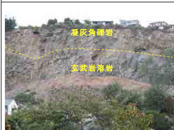
斜面上部が凝灰角礫岩、下部が玄武岩溶岩とおもわれる。斜面肩から崩壊が発生しており、相対的に凝灰角礫岩が崩壊しやすいことが分かる。
