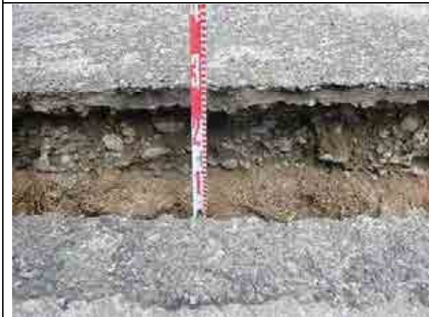
9 15cm 程度の路盤の下は古い盛土もしくは自然地盤である。
