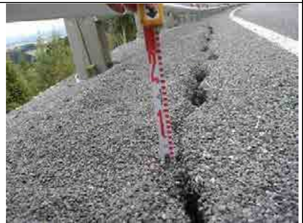
4 フトンカゴの転倒により 5cm 程度の段差が発生している。
