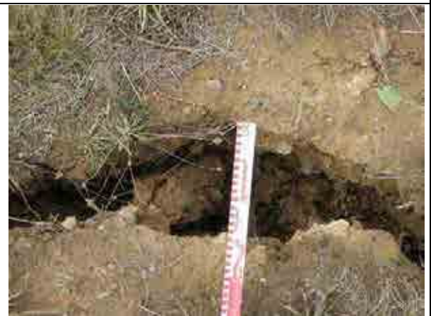
6 写真 5 滑落崖の近景。15cm 程度の開口亀裂が発生している。
