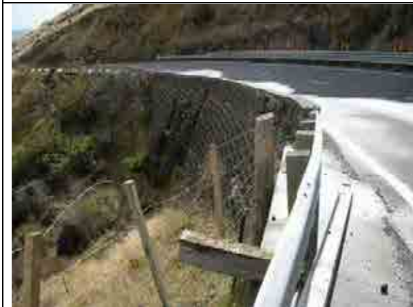
3 高さ 5m 程度の井桁擁壁。路面を含め変状は発生していない。
