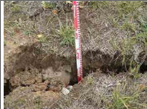
7 写真 5 の滑落崖近景。15cm 程度の落差が形成されている。
