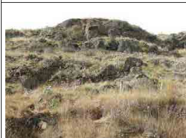
5 斜面部には非常に不安定な玄武岩溶岩が尖塔状に分布している。落石による家屋被害や道路施設被害も発生している。
