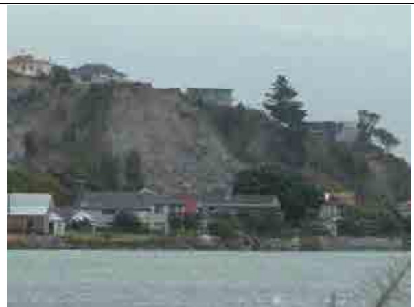
周辺斜面でも凸型斜面部を中心に崩壊が多発している。この付近では玄武岩溶岩がなく、斜面肩から崩壊が発生している。
