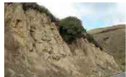
b) 火山灰。固結度は弱く非溶結である。侵食に弱くガリーが発達している。
