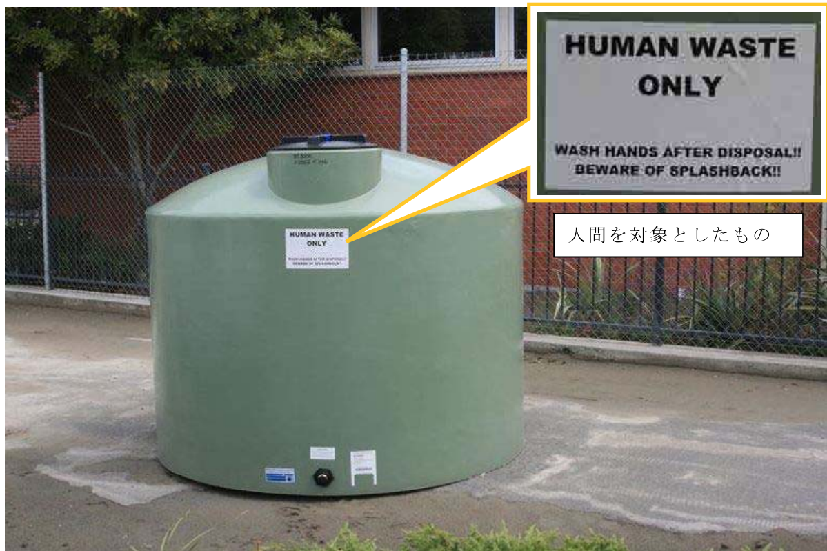
図-8.4.4 尿尿収集タンクの設置状況
