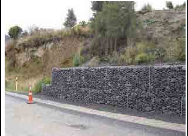
写真-6.3.12 山側切土。部分的にフトンカゴによるのり面保護工が実施されているが変状は発生していない。
