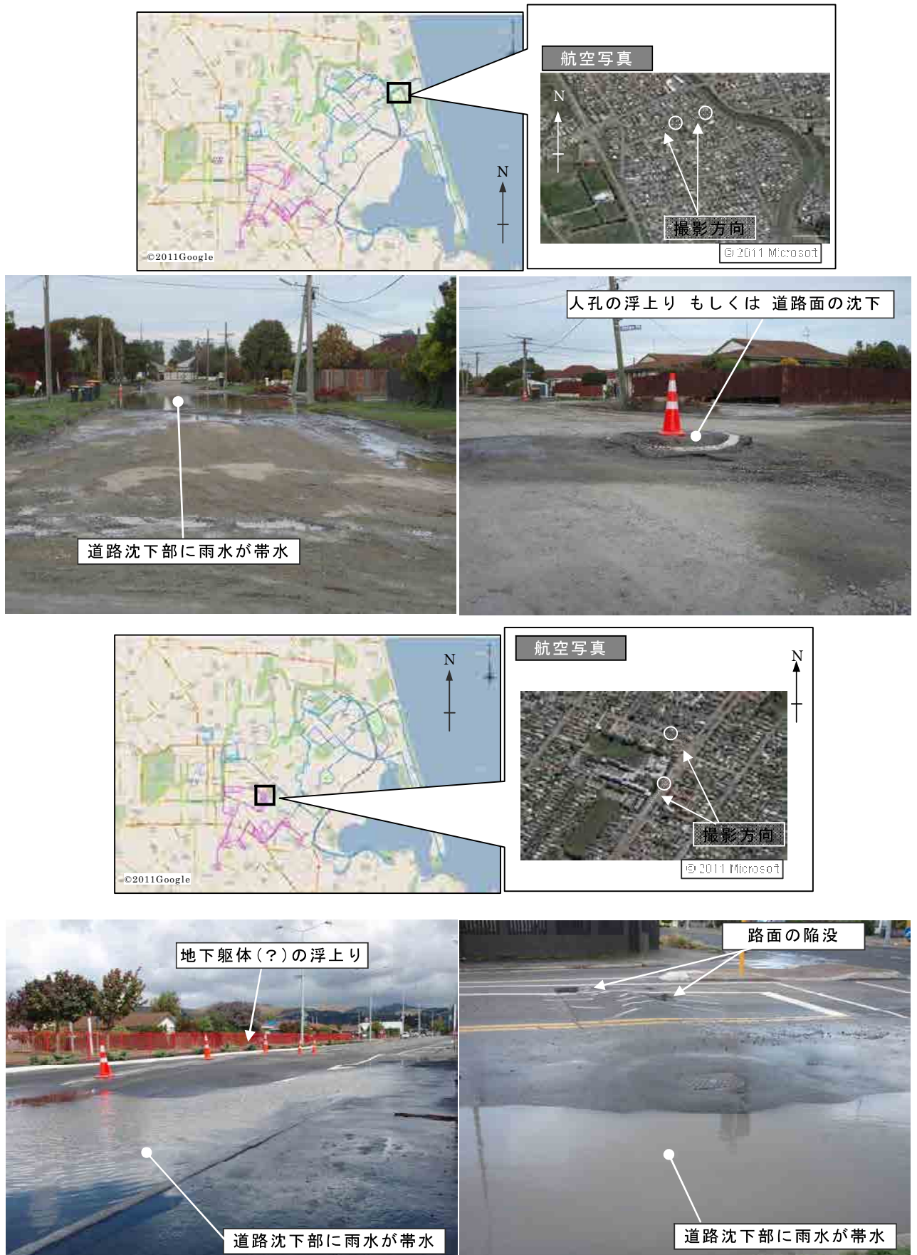
写真-5.3.10 路面の浮上り、沈下・陥没
