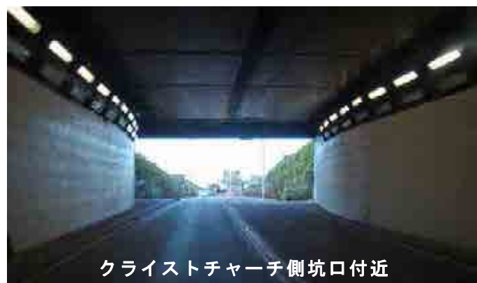
図-8.1.2 リテルトンロードトンネルの坑口付近と中間付近の状況
