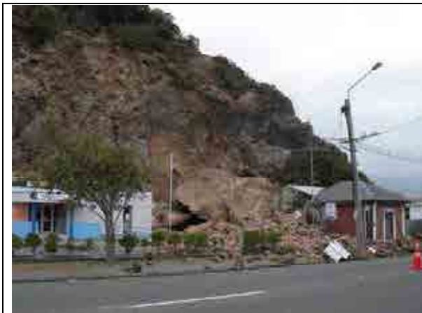
凝灰角礫岩の岩盤崩壊。 最大の岩塊は 10m×15m 程度。
