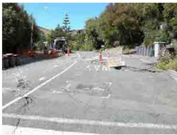
1 頭部滑落崖 写真中央のマンホールは浮き上がりなどの変状は認められない。
