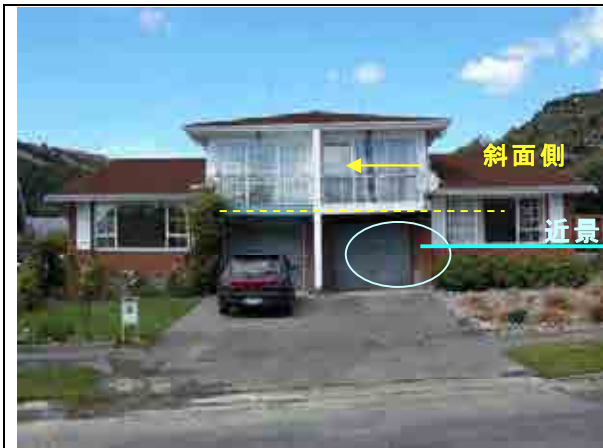
19 写真右側から圧縮を受けやや家屋が持ち上がっている
