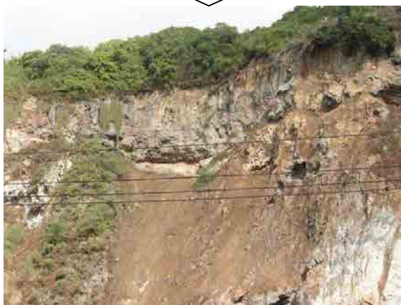
写真 層順の違いによる崩壊形態の差
