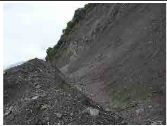
写真-6.3.7. 崩壊部末端は崩土を利用し土堤が作られている。(対策はこれで完了のようである) ポケット部には崩壊面の浸食による崖錐が堆積する。
