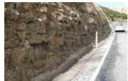
c) 玄武岩質溶岩。比較的硬質で節理が発達する。
