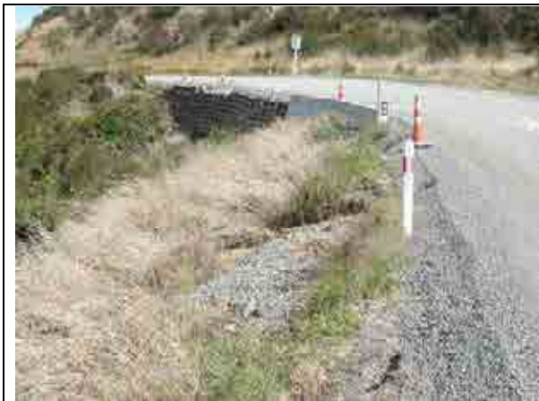
13 井桁擁壁とコンクリート擁壁の複合部。コンクリート擁壁は新しく、2010年の地震被害箇所の可能性がある。
