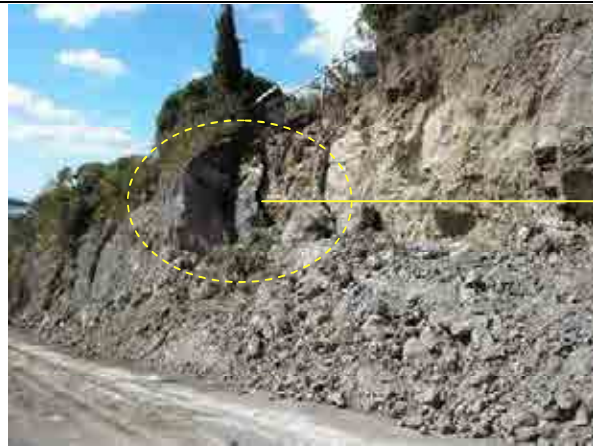
切土のり面の崩壊
