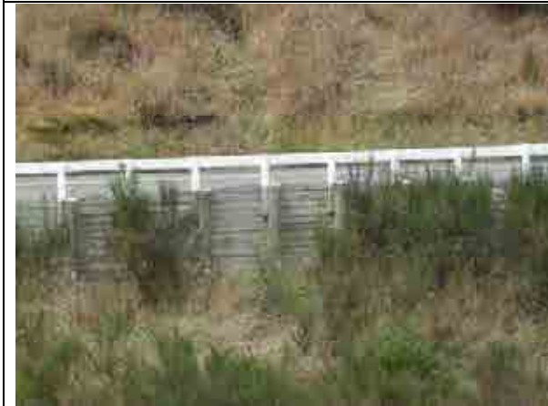
15 木製の擁壁。変状は認められない。
