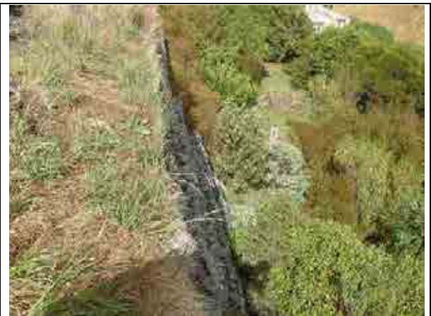
2 写真の盛土のり面。盛土高さ約 3m。フトンカゴが 1:0.3 程度で積まれている。フトンカゴ自体に明瞭な変状はなく、変位を吸収しているようである。
