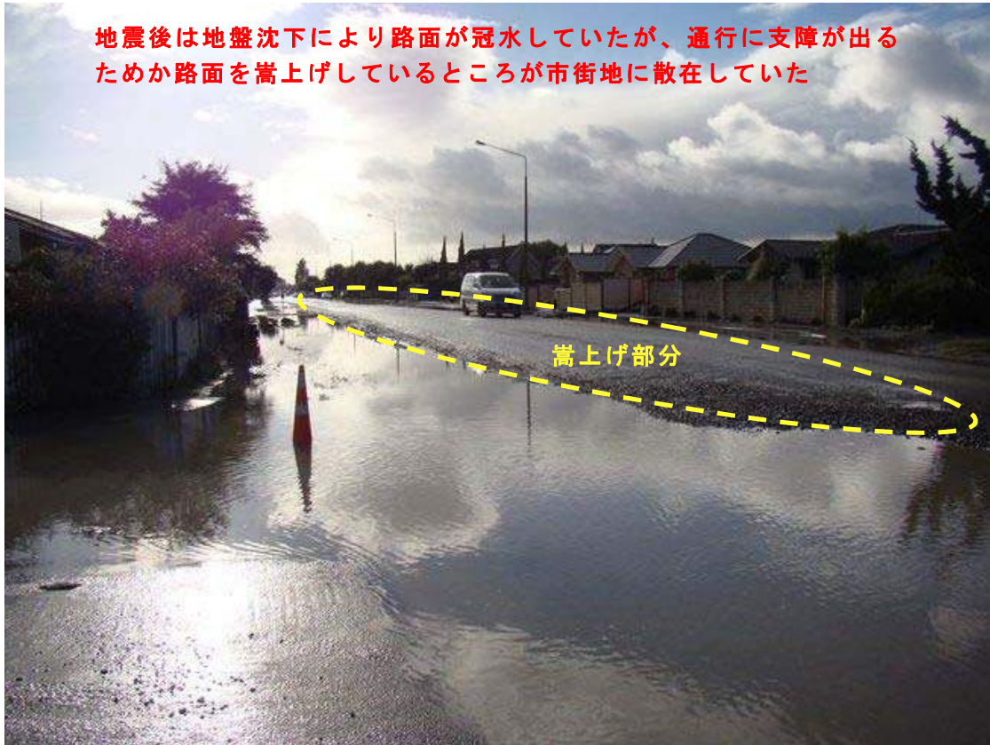
図-8.3.6 路面高さの嵩上げ状況
