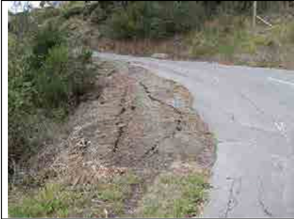
19 MountPleasant Rd.の盛土部の変状。写真 17 とほぼ同様の被災形態を示している。
