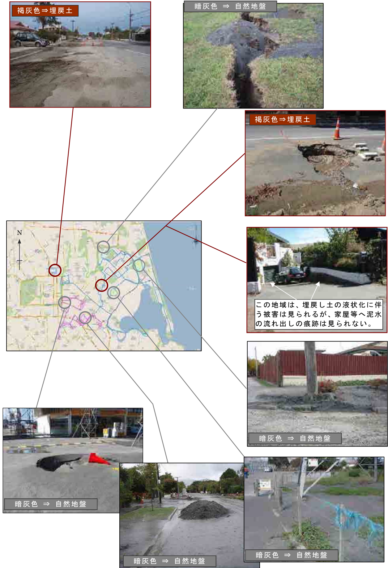
写真-5.3.12 原地盤の液状化、埋戻土の液状化
