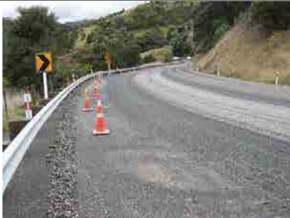
写真-6.3.11 調査地付近は緩慢な地すべり変動の影響か道路補修工事が実施されていた。路面に変状は認められなかった。
