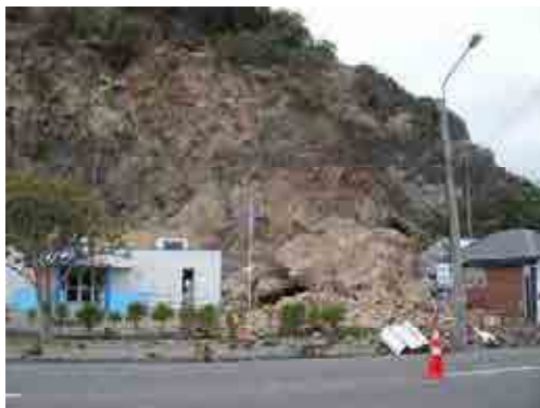
写真-6.1.1 レッドクリフズにおける岩石崩壊
