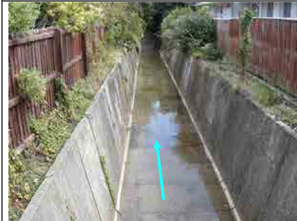
15 斜面傾斜変遷線の小河川。三面張り水路であり、顕著な変状は認められない。
