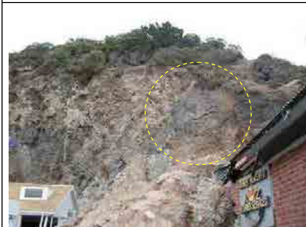
上記崩落部の剥離跡。灰色を呈しており酸化は弱い。崩落状態から推定すると局部的な凸型斜面であったと考えられる。
