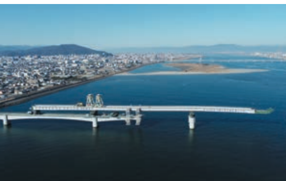
【写真上】補助桁併用張出架設 （河川上空から補助桁による資材搬入）
