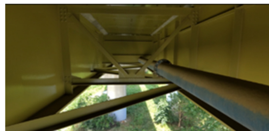
J2搭載カメラでの撮影画像 （トラス等の橋梁狭隘部）
