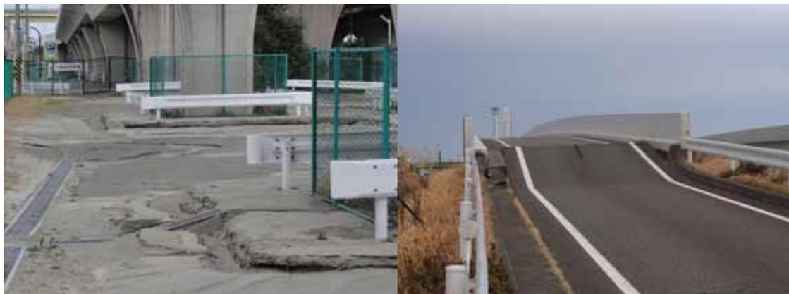
高架橋の地盤。盛大な噴砂、周辺地盤沈下。
