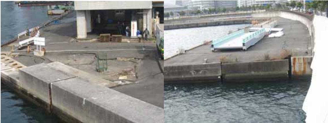
左：横浜中央市場。みなとみらい橋から。沈下しているが噴砂は見えない。
