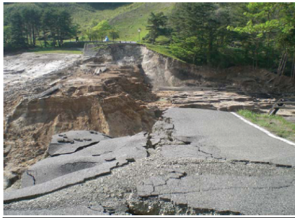
② ダム軸右岸側から左岸望む 左岸側の堤防は残存し、堤体の下流側は 筋状に流水で浸食され、流出する。
