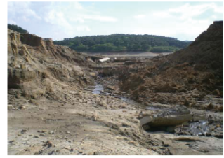
④ 右岸側破堤断面
