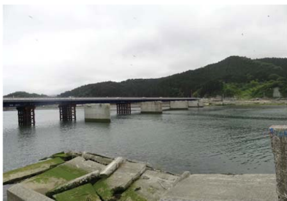
写真 5 発災後半年 (H23.9 仮橋)
