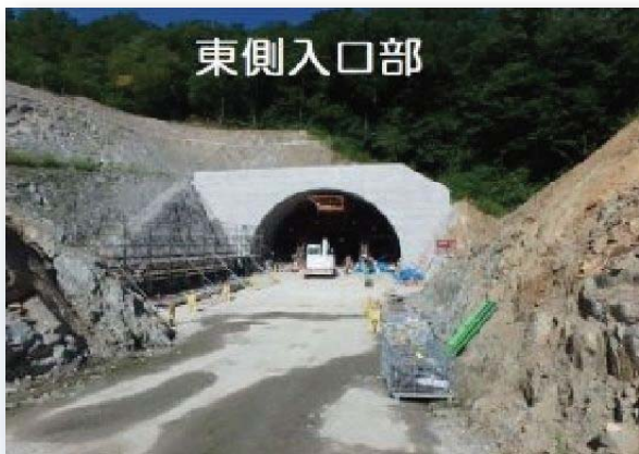
宮古盛岡横断道路（小山田トンネル）
