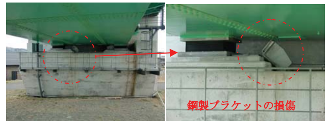
写真13 変位制限装置の損傷（新天王橋）
