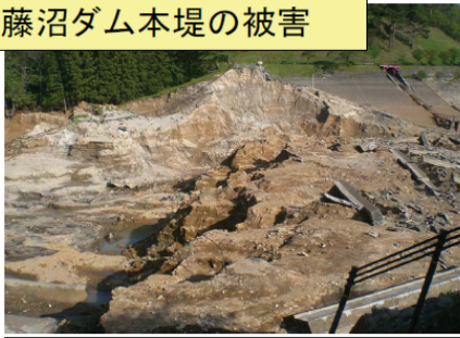
③ ダム軸左岸側から右岸望む 右岸側の堤防は堤長の1/3が全て流出 する。最初の破堤箇所・湖水の集水箇所
