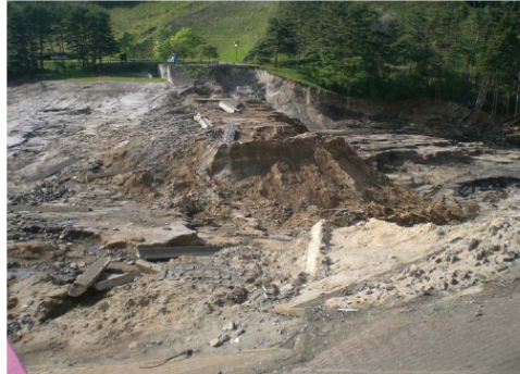
図3 藤沼ダム堤体の被害状況
