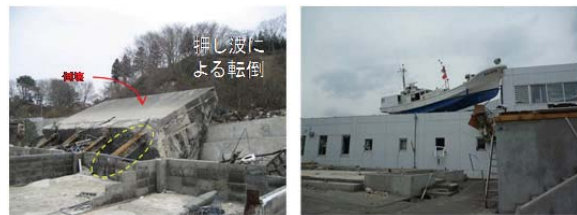
写真1 防潮堤破壊と堤内の様子
