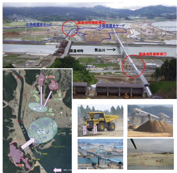
図4 施工現場の様子
