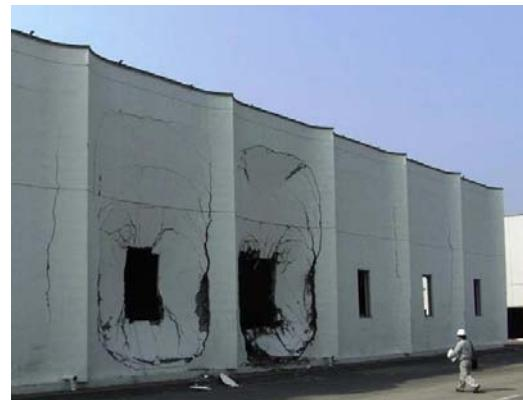
写真 5 南蒲生ポンプ場の津波による被災状況
