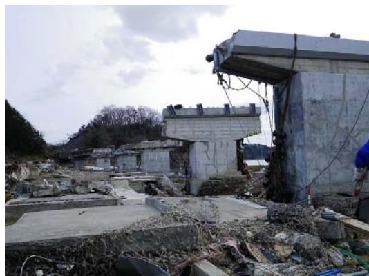
写真 4 道路橋の津波による桁の落下の状況
