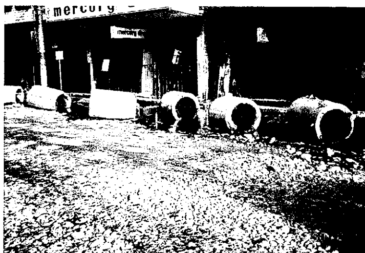
↑写真-3 ダグパン市 — 下水道管内の土砂堆積 (掘りおこされたあと)
