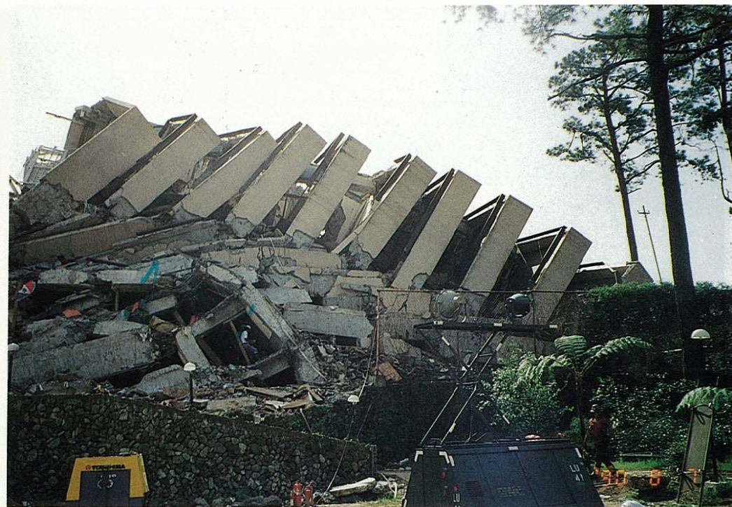
口絵写真-4 バギオ市 — ハイアットテラスホテルの崩壊
