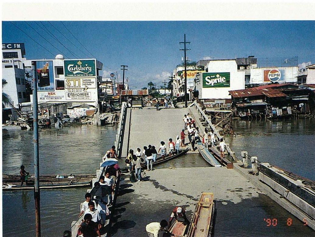
口絵写真-1 ダグバン市 — マグサイサイ橋の落橋（小舟による仮橋？）
