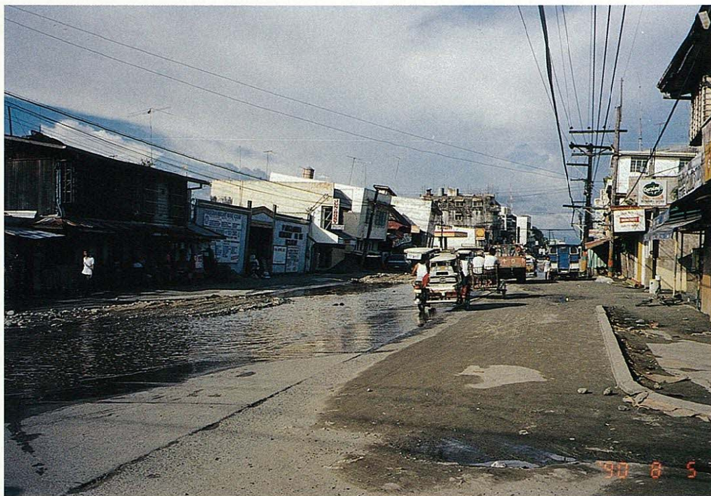
口絵写真-2 ダグバン市 — ペレス通りの状況（大部分の建物が沈下・傾斜している）
