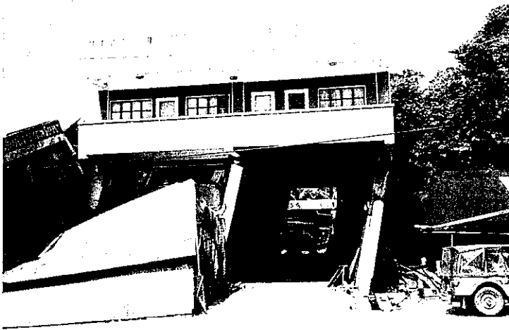
←写真-9 アゴー市 — 2階建て建物の被害
