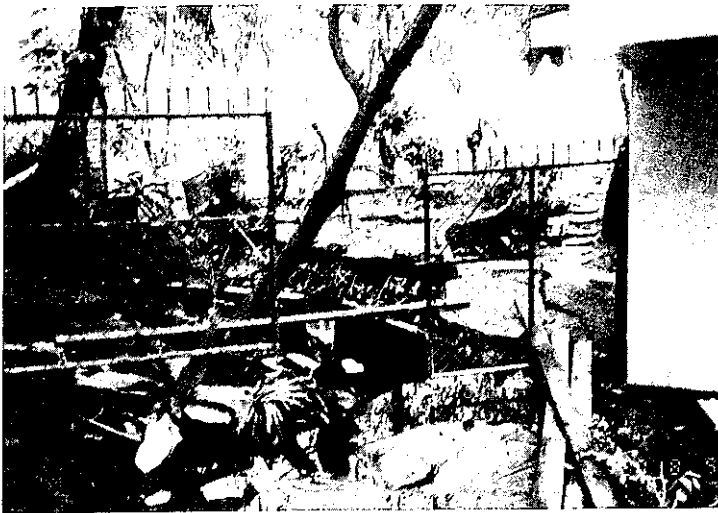
↑写真-5 ダグパン市 — マグサイサイ橋左岸上流、 病院の円形建物（左側）と地盤の移動に よるフェンスの開き
