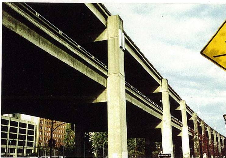
写真-31 (右) S-480エンバカデーロ・フリーウェイ —— 海側から北西方向 (図-5 参照) を見たもの。外見上は I-880 と同様の構造のように見える。
