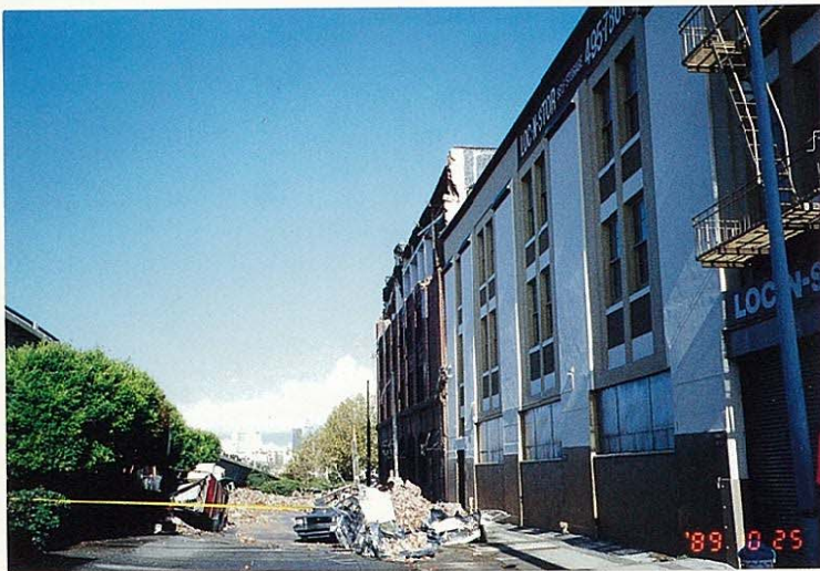
写真-7 (上) サウスマーケット地区 タウンゼント通りのビル被害 —— 上部のレンガ積みがくずれ落ち、 下の車を直撃、5人が死亡した。 この写真の左手はI-280号線の ランプ(コンクリート橋)で、橋 の下には多くの噴砂が見られた。 橋に被害は確認できないが、通行 止めになっており、何らかの被害 があるものと推定される。
