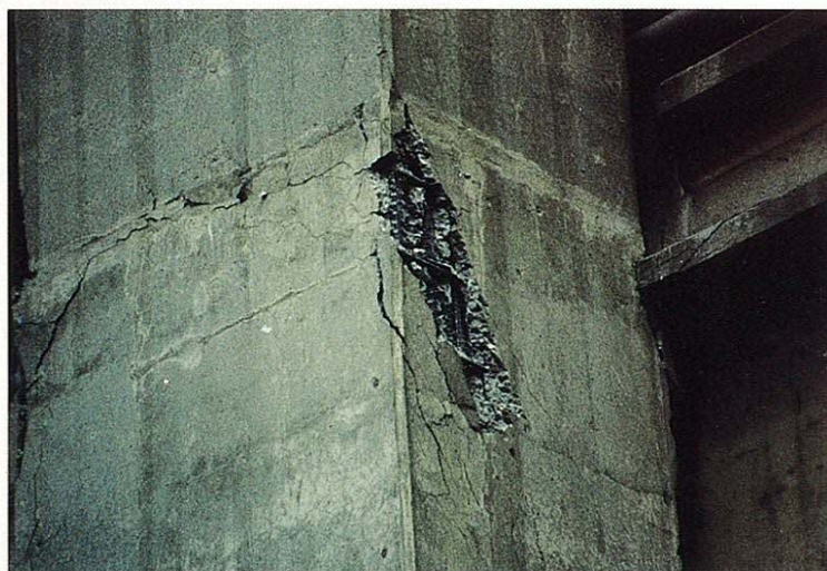
写真-34 (左) S-480 —— 下部の柱のヒンジ部 (と思われる箇所) に亀裂がある。上部のヒンジ部分には補強したと思われる部材が見える (ただし、この補強は上部のみで、全ての橋脚にあるわけではない)。
