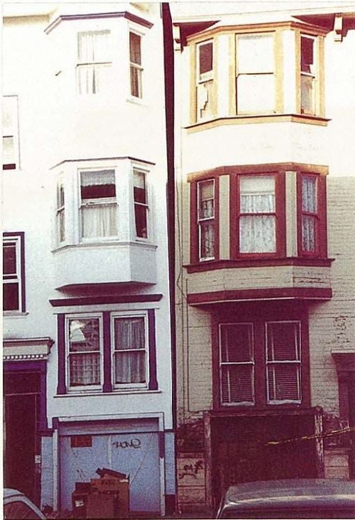
写真-5 (左) サウスマーケット地区の家屋被害 —— ぴったり建てられた家の間にすき間が見え、 傾斜していることがわかる。
