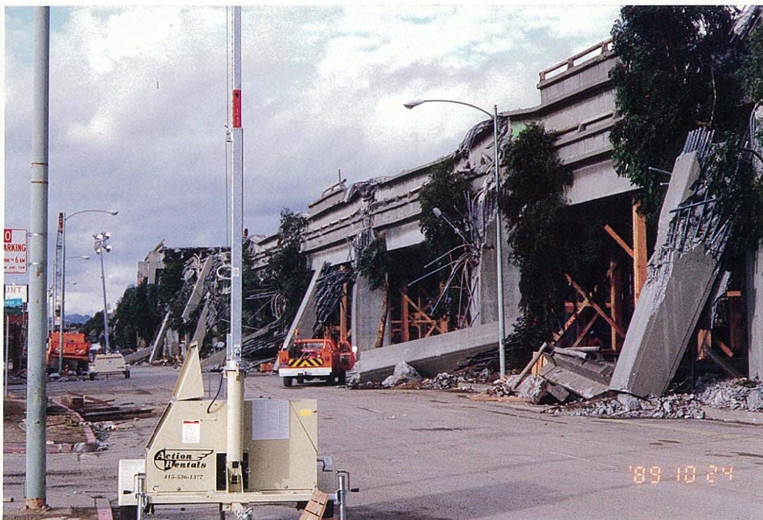
写真-17 I-880号線（ニミッツ・フリーウェイ，オークランド）の被害
