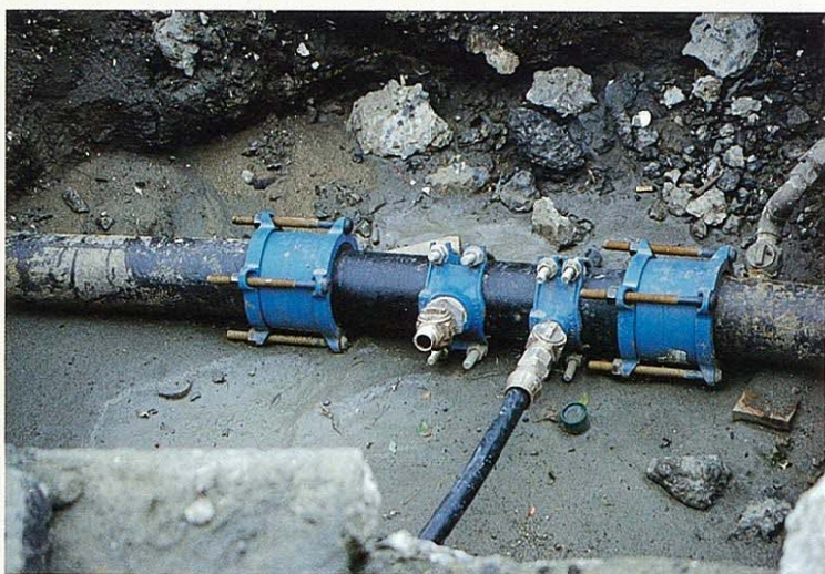
写真-14 (上) マリーナ地区で見られた水道管の補修状況 —— 铸铁管の給水管分岐部の被害を補修したものと 考えられる。
