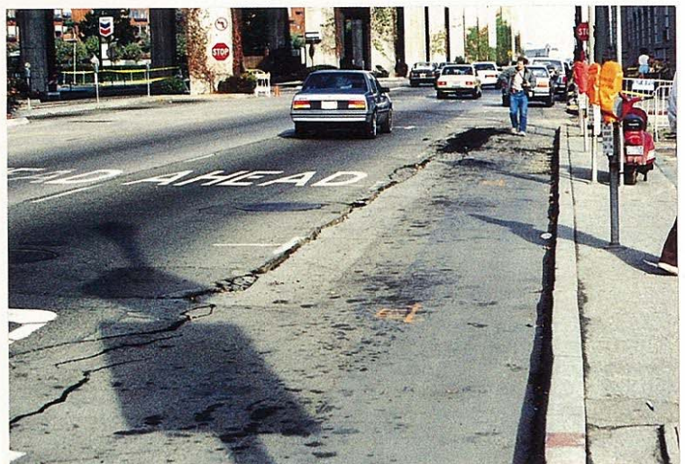
写真-8 (下) エンバカデーロ通りの変状 —— 路面が沈下している。近くには噴砂も 見られる。左手の橋脚は写真-31~34 のS-480, エンバカデーロ・フリーウ ェイ。この手前で橋脚の被害があった。
