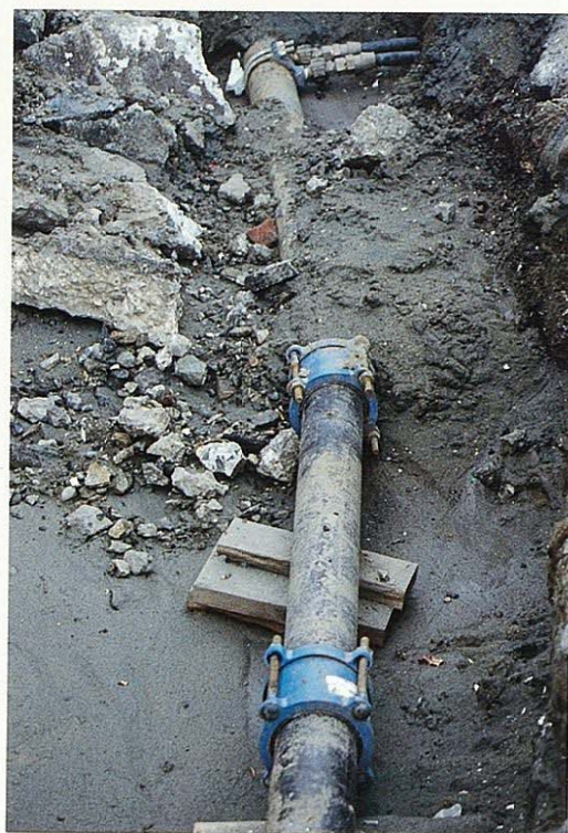
写真-15 (下) マリーナ地区で見られた水道管 の補修状況 —— 铸铁管
