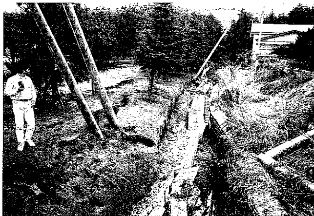
写真④-2 中の沢小学校敷地北側の水路崩壊
