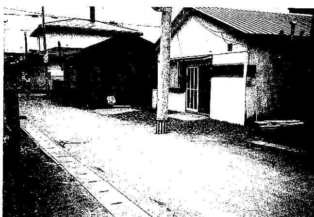
写真⑨-4 七重浜1丁目 電柱の沈下
