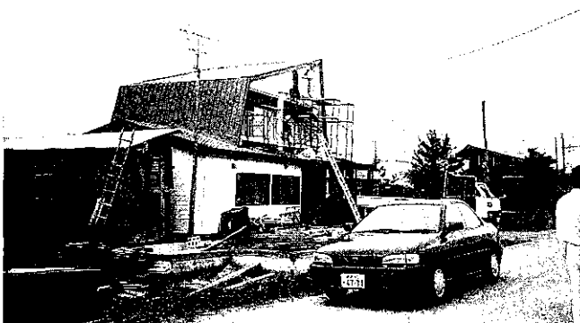
写真②-3 八雲町山崎、民家の被害（修理中）
