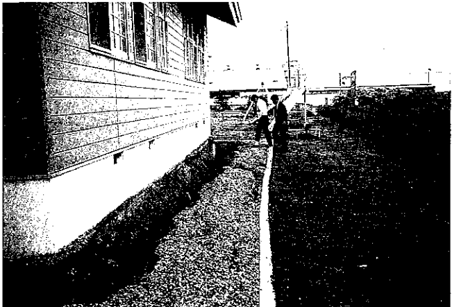
写真④-5 中の沢小学校校舎裏側の沈下(写真奥が国道5号、この部分の杭は破損、傾斜している。右写真)
