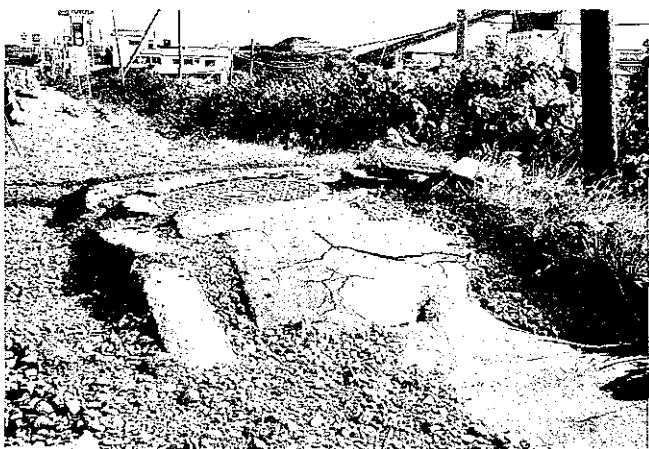
写真⑧-5 柳崎橋左岸側取付部におけるNTTマンホール突出 (周囲地盤の沈下か?)
