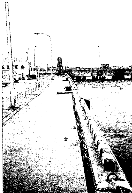
写真⑩-6 同, 岸壁のはらみ出し
