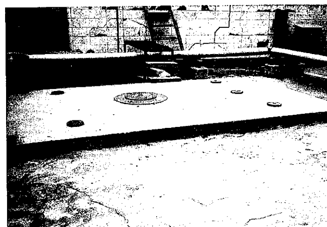
写真⑩-9 同, コンクリートボックスの浮上
