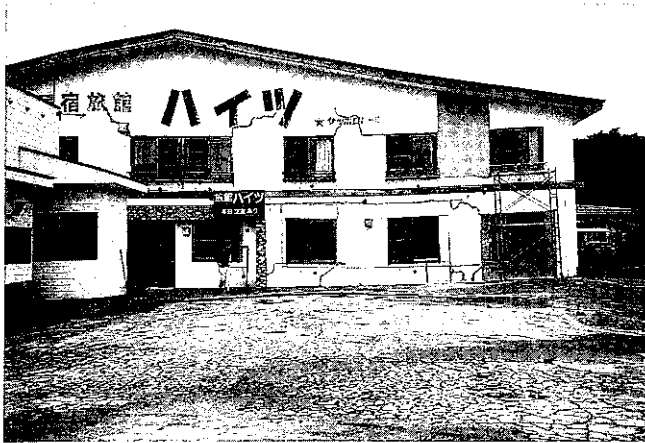
写真①-1 赤井川 民宿の被害, 中央部が液状化により沈下した。
