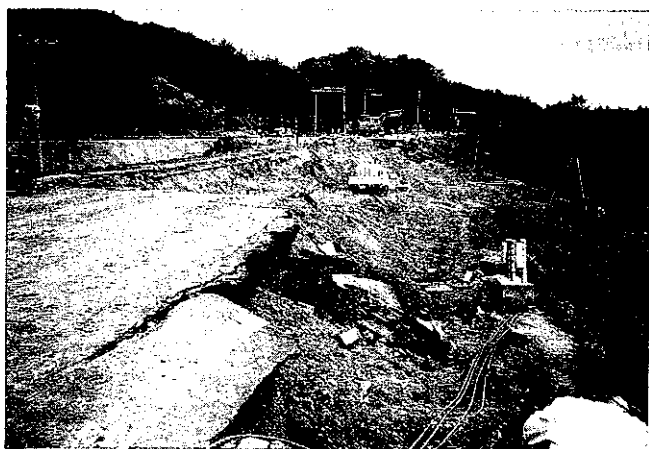
写真⑤-1 国道5号 長万部町知来地先盛土の斜面崩壊
