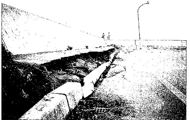
写真①-6 森漁港, 岸壁背面地盤の沈下(約50cm)
