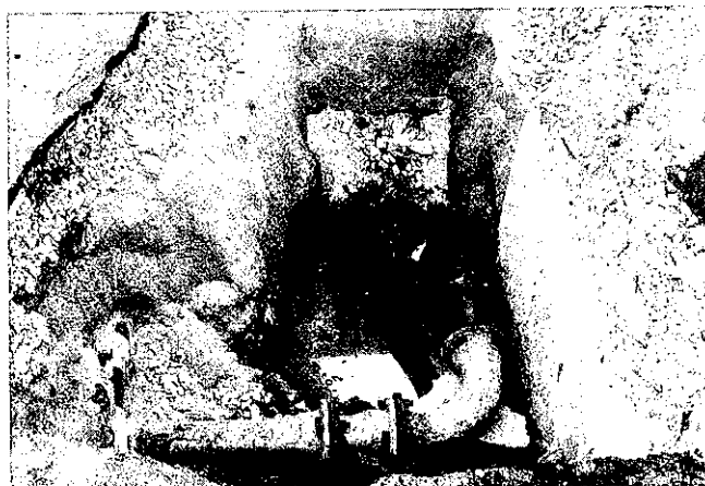
写真⑩-7 東日本フェリーターミナル, 復旧工事中の給水管 (1CP φ100)
