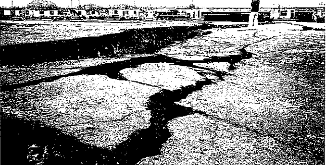
写真①-7 森漁港, 岸壁背面地盤の亀裂・沈下
