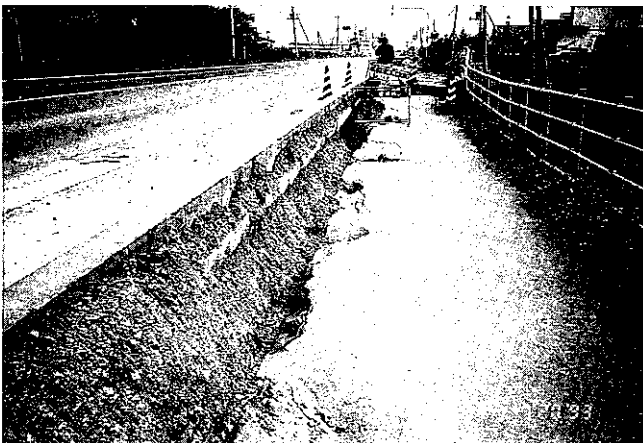
写真④-8 国道5号中の沢周辺歩道部のすべり・沈下 (写真奥に④-7のNTTマンホールが見える)
