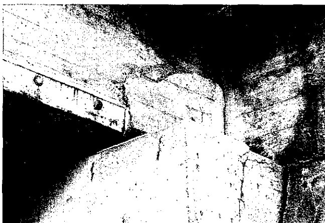
写真②-6 山崎橋、主桁コンクリート剝離
