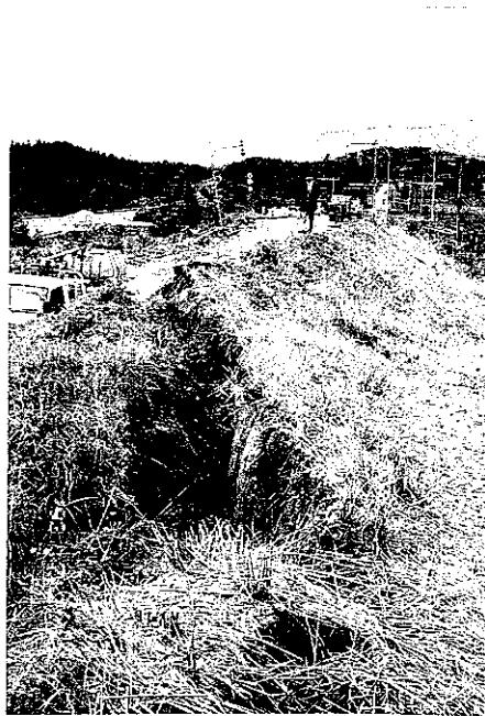
写真⑤-3 盛土天端におけるすべり境界部
