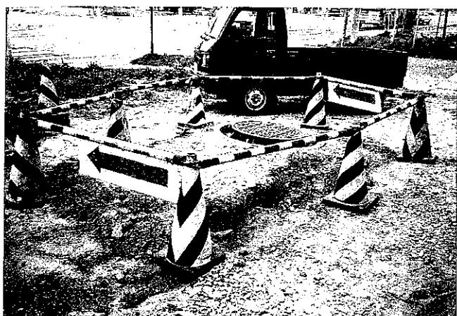
写真⑨-3 久根別2丁目 国道 228号脇のNTTマンホール浮上
