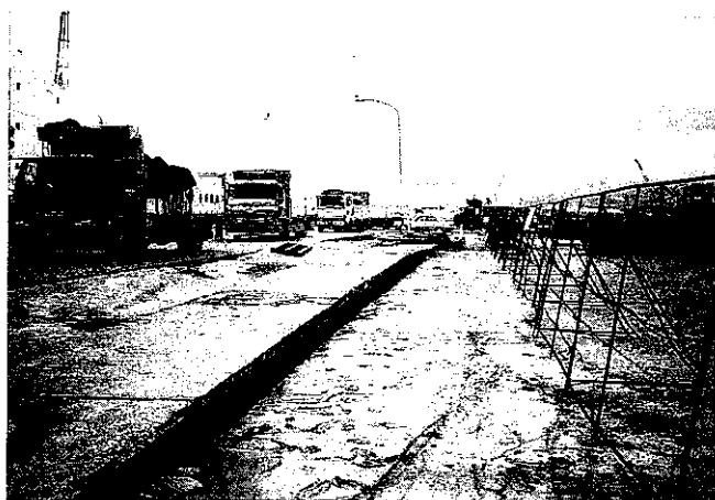
写真⑩-1 万代埠頭、地下ダクトの浮上
