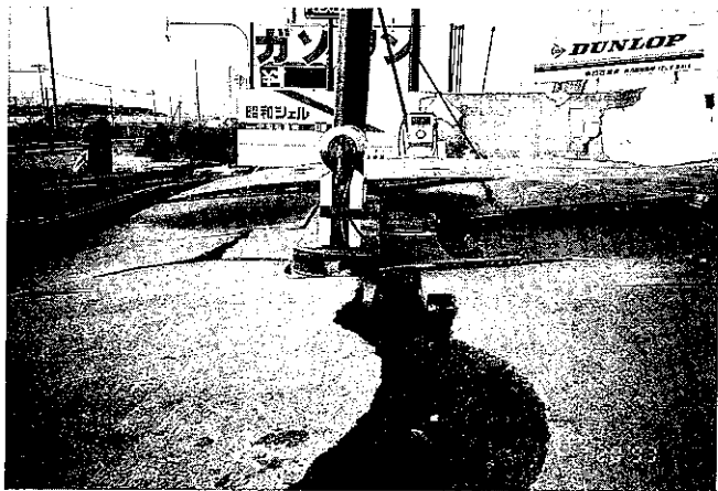
写真④-9 大浜地区 ガソリンスタンドの被害（亀裂・沈下・タンク浮上）
