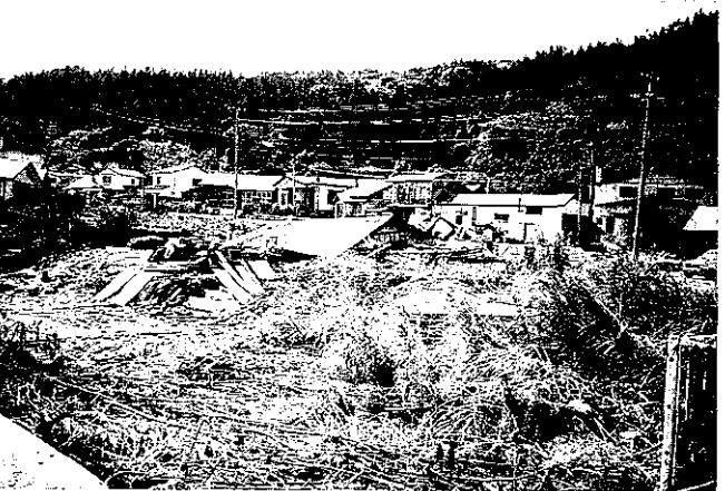
写真⑦-1 大成町 津波による被害
