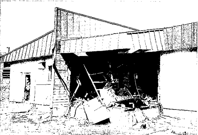
写真⑦-2 津波による保育園？の被害
