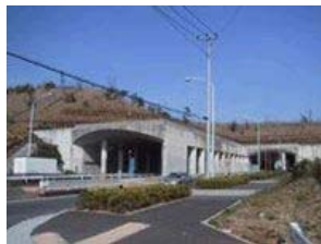
▲小山長池トンネル(東京都)
