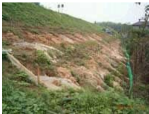
大径棒状補強体施工直後 ▲⑤盛土のり面耐震補強(水資公団)
