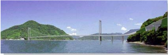
▲一般県道龍ヶ岳御所浦線御所浦第2架橋
