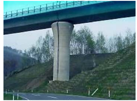
写真-1.6 張出式橋脚(円形断面)
