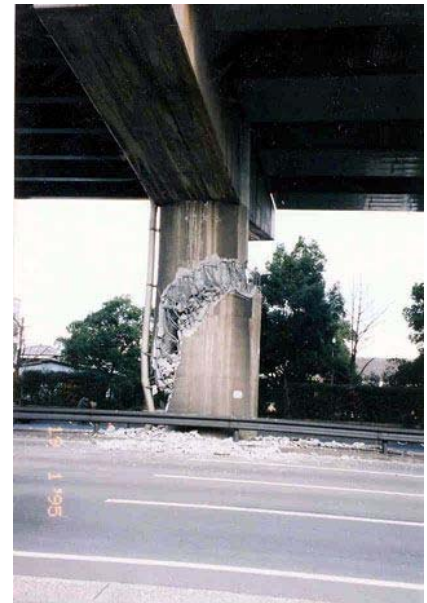
写真-2.4 せん断破壊
