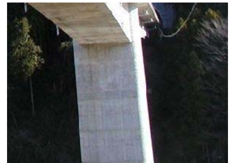
写真-1.3 壁式橋脚(矩形断面)
