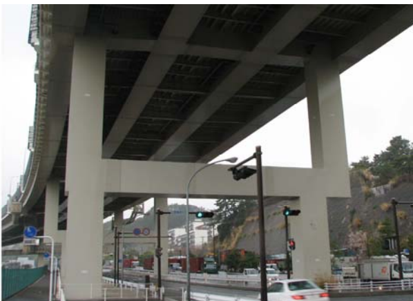
写真-1.1 鋼製橋脚（ラーメン式）
