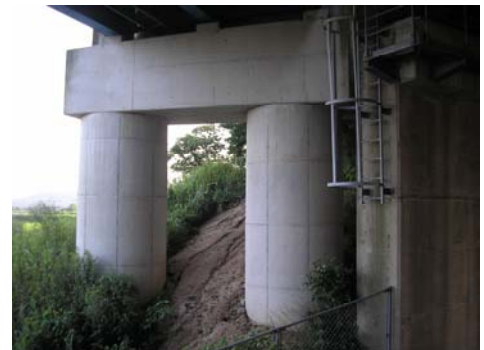
写真-1.7 パイルベント式橋脚
