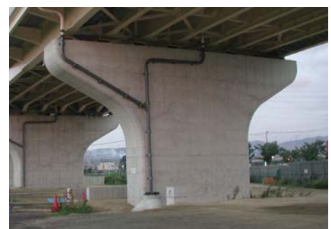
写真-1.5 張出式橋脚(矩形断面)
