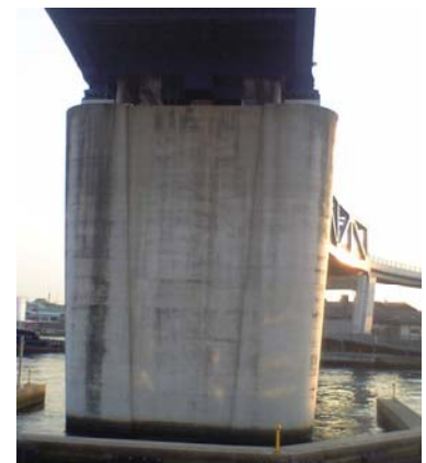
写真-1.4 壁式橋脚(小判型断面)
