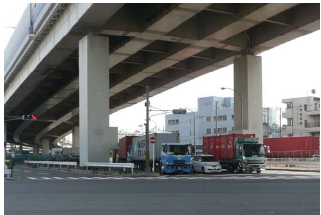
写真-1.2 鋼製橋脚（単柱式）
