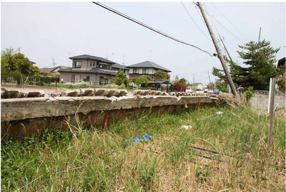
水路の裏側。鋼矢板を打ち込み、底版を打設、蓋をかけたもののよう。
