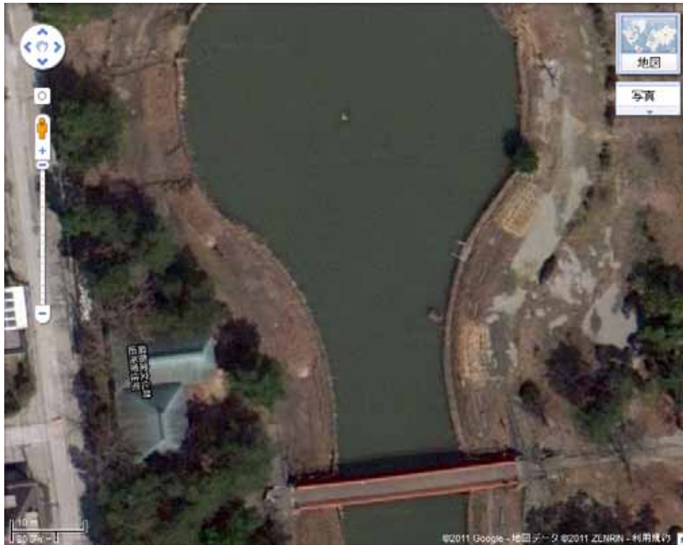
池の周辺には噴砂、地割れが見られる。画面下が浪逆橋。
