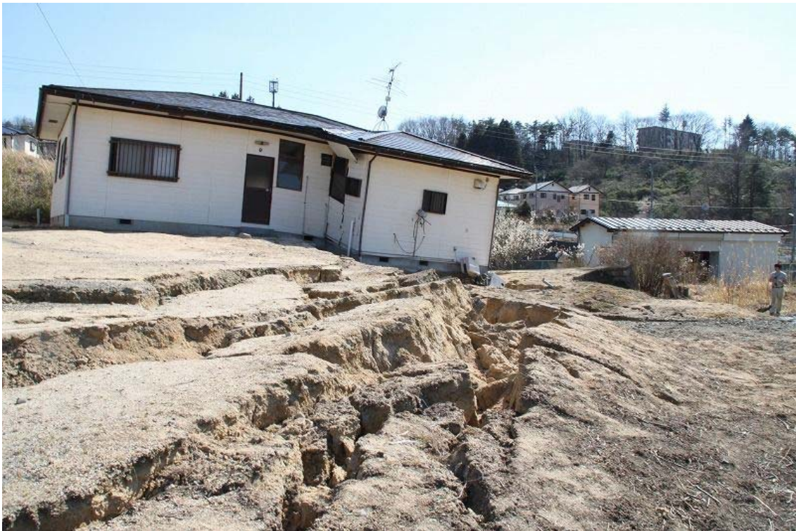
傾斜した家屋と地割れ
