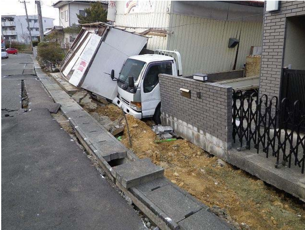
航空写真内③(道路を挟んで小学校側)。支持地盤の崩壊によって家屋が沈下し、道路から離れてしまっている。
