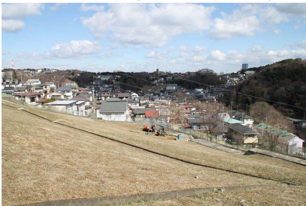
3号緑地。特に被害は見られない。
