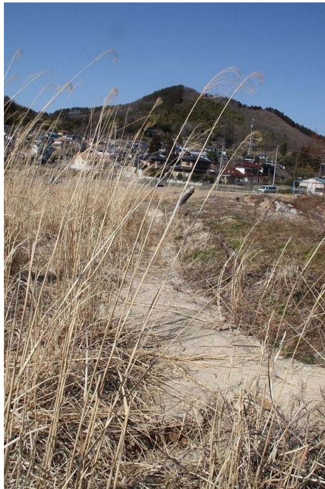
上記の家の下の地割れと噴砂
