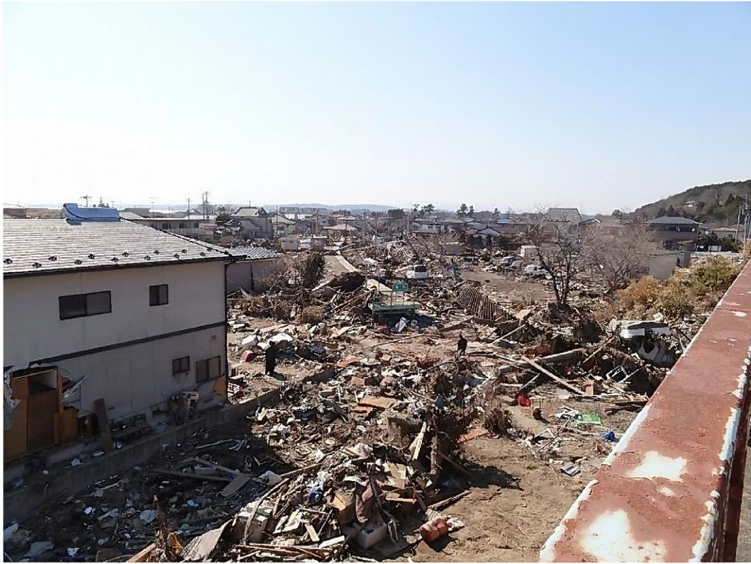
東名駅近くの跨線橋からがれきに埋まった東名駅を望む
