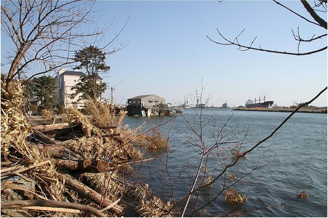
南を望む。大型の船が座礁している。
