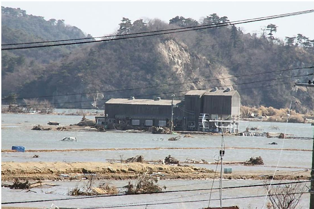
水没地区のほぼ中央の建物
