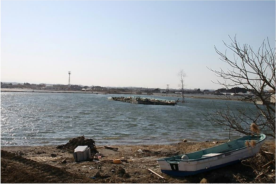
北側を望む。中央が流された橋桁。
