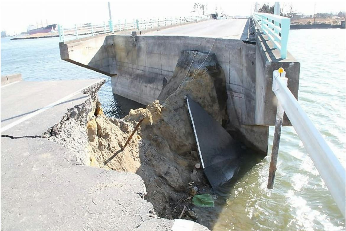
橋台部分。中央径間以外は健全に見える。
