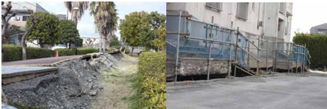
左：公園が盛り上がっている。下には応急給水槽？ 右：周辺が沈下したマンション
