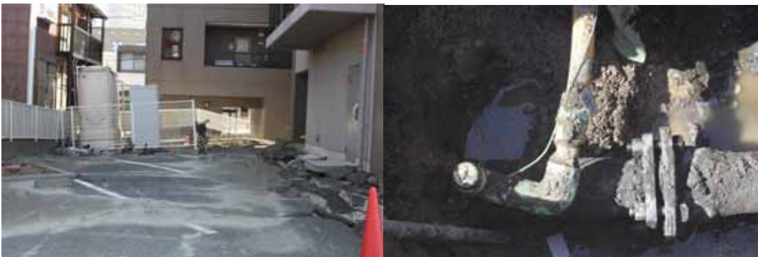
左：右上のビルの裏。 右：ガス管の復旧
