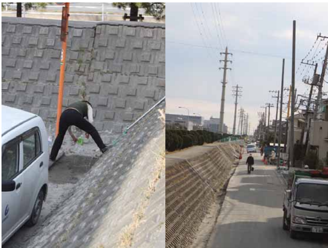
旧堤防の海側に水道の仮設地上配管、堤防を越えて応急給水栓が設けられている。
