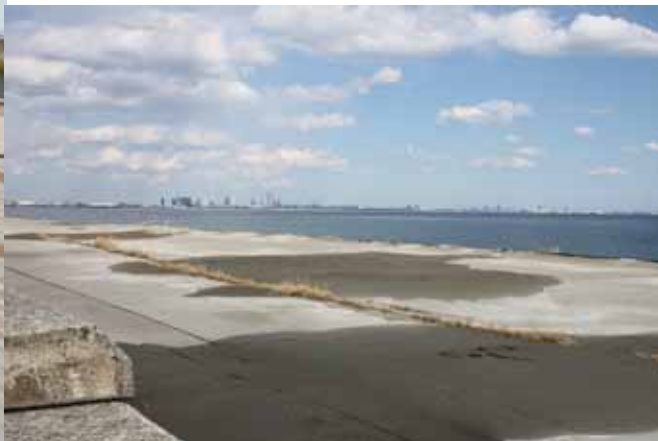
浦安市総合公園。左：堤防脇の沈下。 右：堤防前面の噴砂
