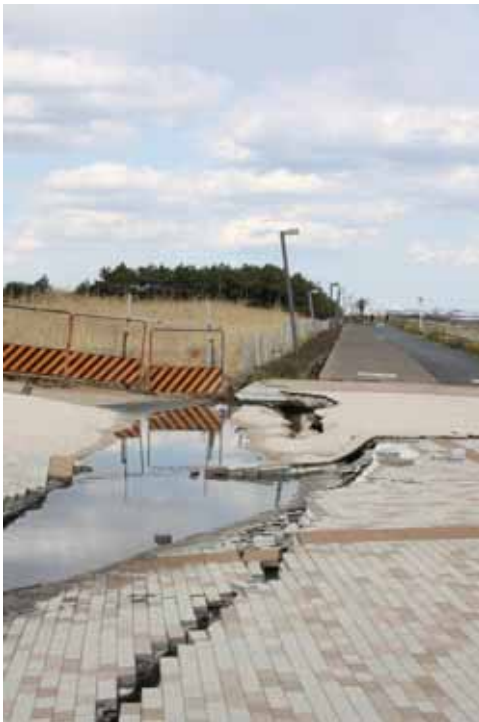
浦安市総合公園。左：堤防脇の沈下。 右：堤防前面の噴砂
