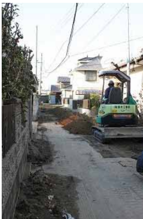
ガス管復旧中
