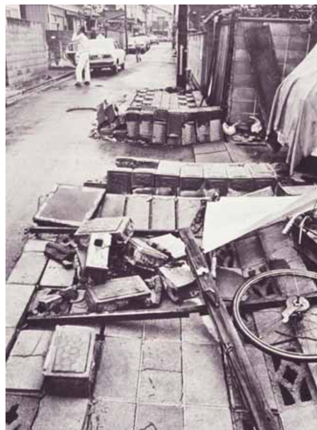
ブロック塀の被害、死者11名
