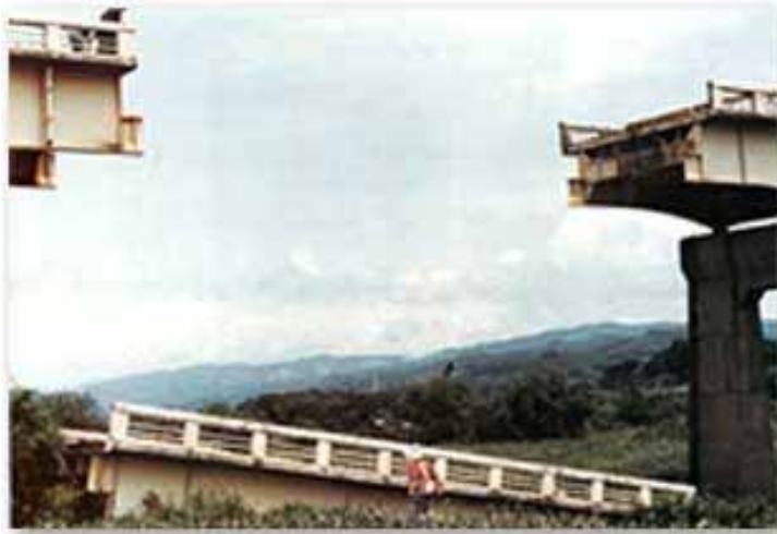
錦桜橋の被害(写真;東北地方整備局)
