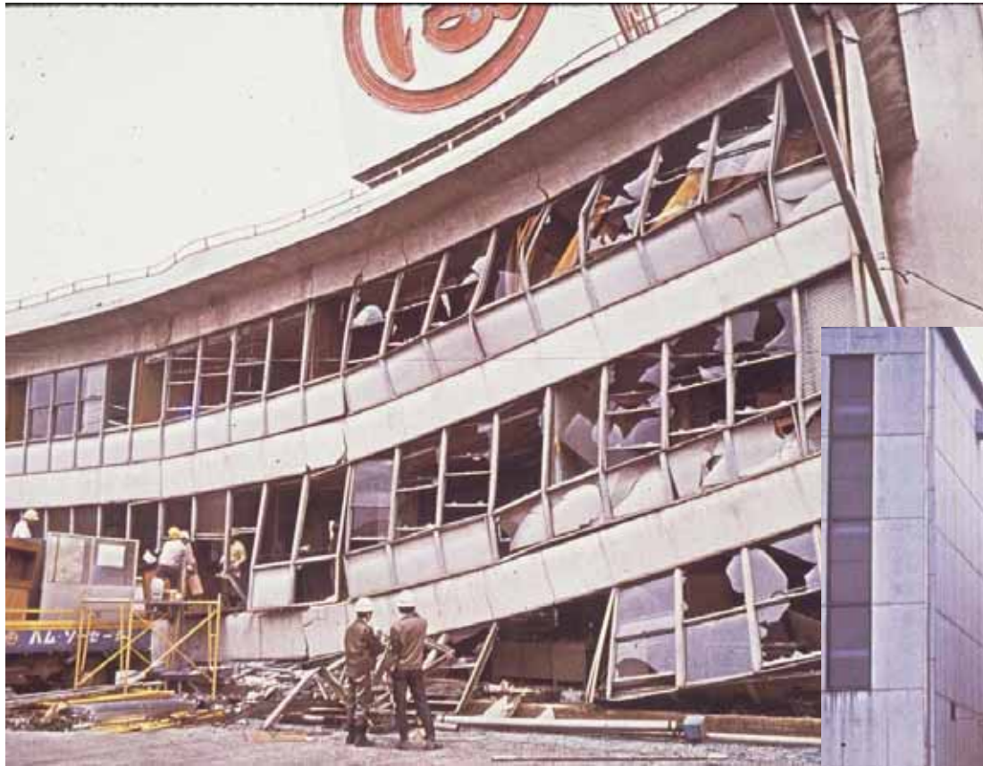
大洋漁業 ピロティ構造の被害
