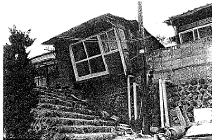
写真8.2 この建物も傾斜は極く、平家建が が地すべりによりブロック壁を倒して 倒出した例である（鎌倉市緑ヶ丘1丁目 高岡義樹調査写真撮影）
