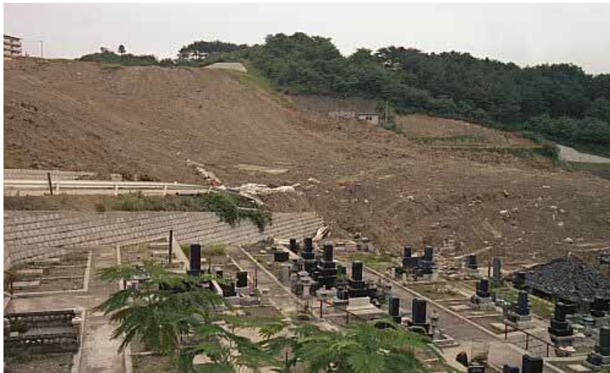
白石市の造成地崩壊(写真;東北学院 大学松本研究室)
