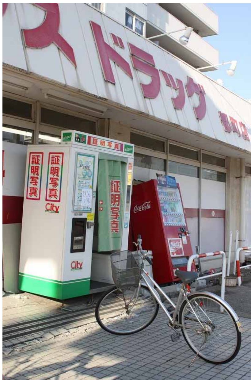
上記建物の自動販売機の転倒
