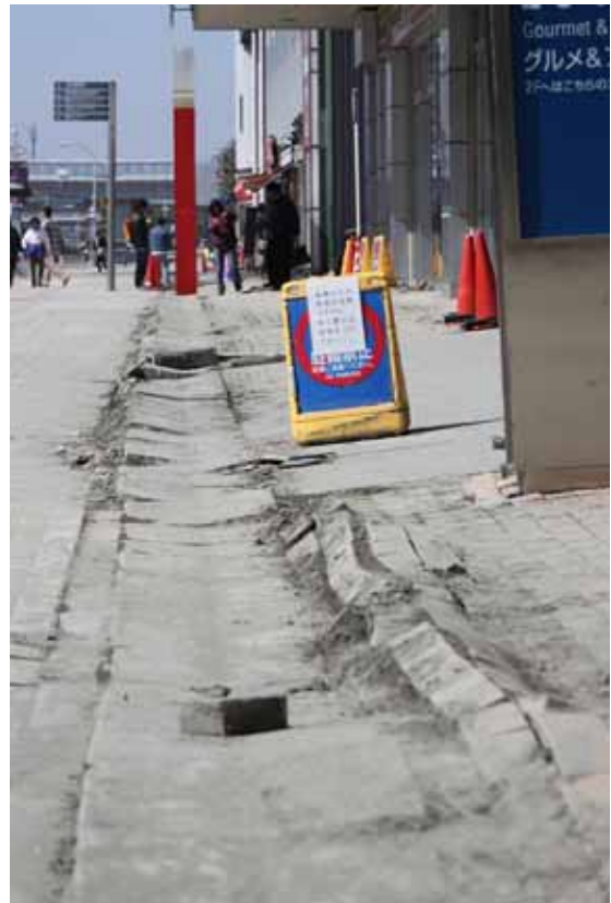
海浜幕張駅前（北側）の噴砂、沈下。左は駅に接した建物、右は駅正面の建物。
