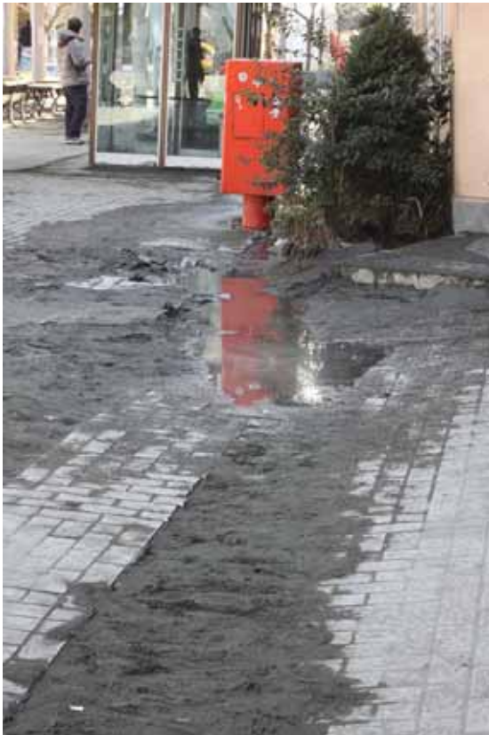
海浜幕張駅前（北側）の噴砂、沈下。左は駅に接した建物、右は駅正面の建物。
