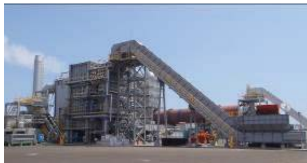
写真2 仮設焼却炉（手前：ストーカー炉，奥：キルン炉）
