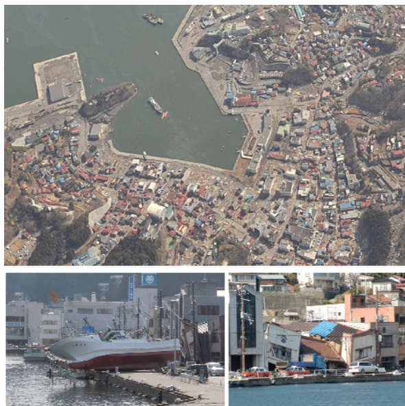
写真2 内湾地区の被災状況
