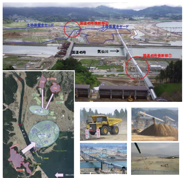
図4 施工現場の様子
