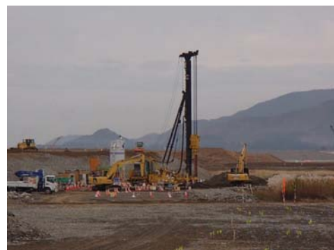
写真 3 平成 27 年 冬 地盤改良工 (CDM)
