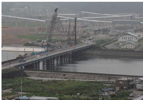
写真 6 平成 25 年夏（既設橋の基礎撤去）
