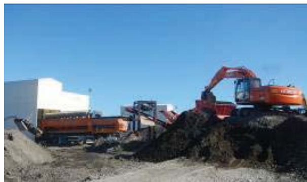
写真3 土壌の改質・選別作業状況
