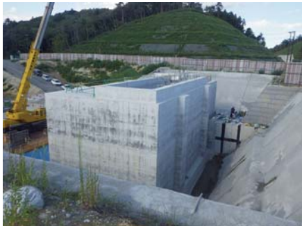
地下通路階段室
