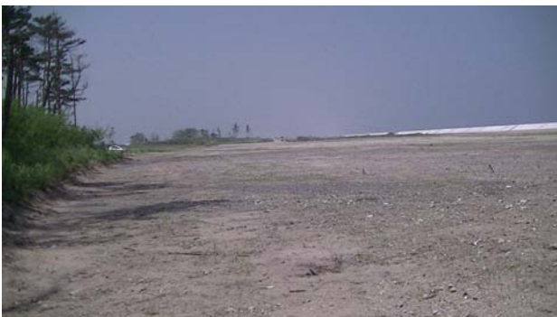
写真4 二次仮置き場解体跡地（H26.6下旬）
