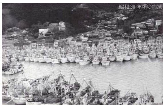
写真1 賑わっていた頃の内湾地区
