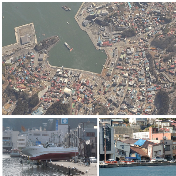
写真2 内湾地区の被災状況
