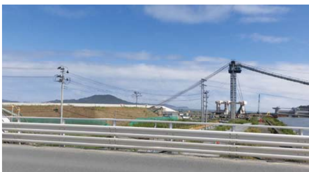
写真 2 ベルコン施設撤去途中段階 (H28.6)
