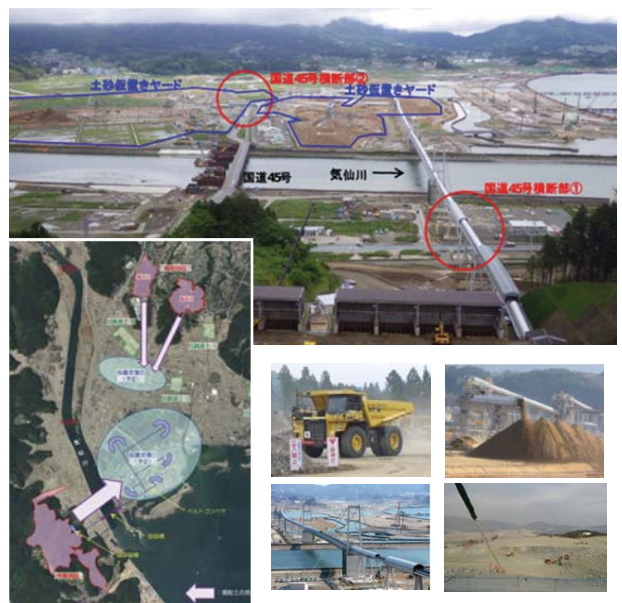
図4 施工現場の様子
