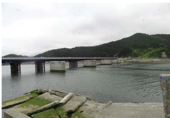
写真 5 発災後半年（H23.9 仮橋）
