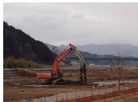
写真 4 平成 27 年 冬 地盤改良工 (PB)
