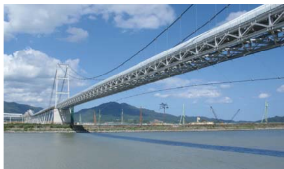
写真 7 平成 26 年 夏 ベルコン橋 稼働
