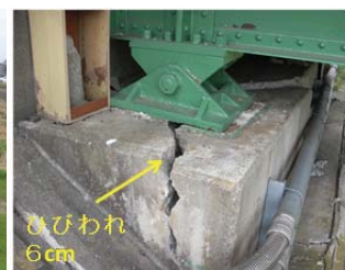
写真17 橋台固定支承部
