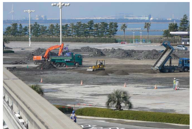
写真8 ディズニーランド駐車場での噴砂の発生状況 (片付作業中)
