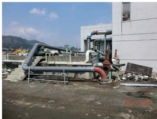
写真11 流入ポンプ棟からの仮配管（大船渡市）
