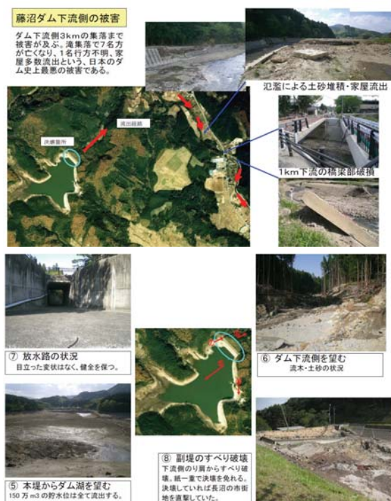
図2 藤沼ダム下流側等の被害状況
