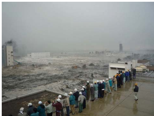
写真5 津波に襲われる南蒲生処理場(仙台市 web)
