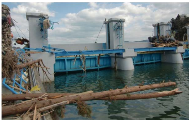
写真7 水尻川河口付近の防潮水門
