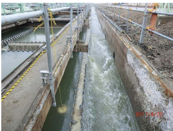
写真10 暫定的な塩素消毒の事例（宮城県内）
