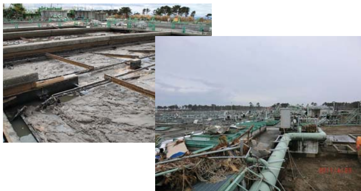
写真6 津波被害を受けた処理場の事例(宮城県内)
