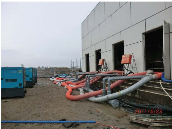
写真8 流入ポンプ棟からの仮配管（宮城県内）
