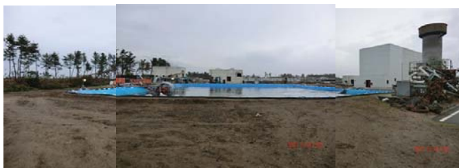
写真9 場内に設けた仮設沈殿池（宮城県内）
