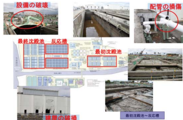
図 6 蒲生浄化センター被災状況
