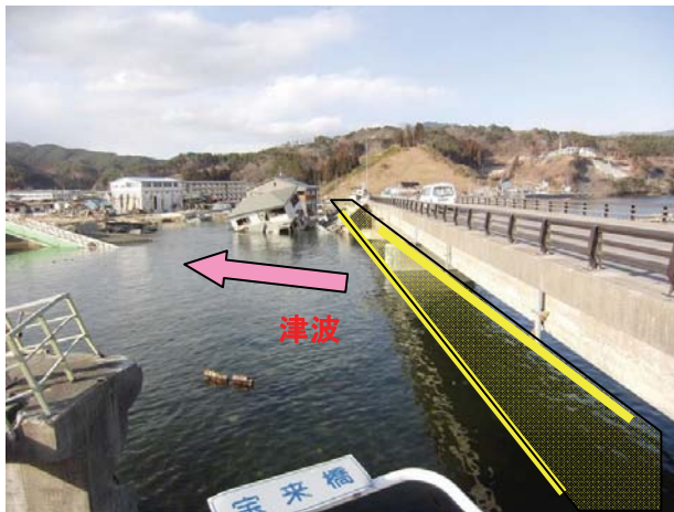
写真 10 宝来橋側道橋の流失状況
