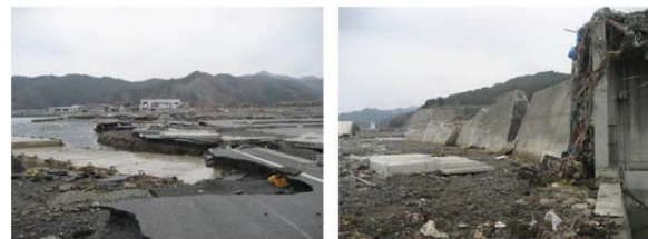
写真1 防潮堤破壊と堤内の様子
