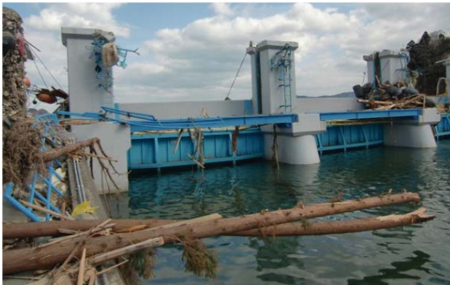
写真7 水尻川河口付近の防潮水門
