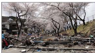
写真 27 嬉石公園の被災状況
