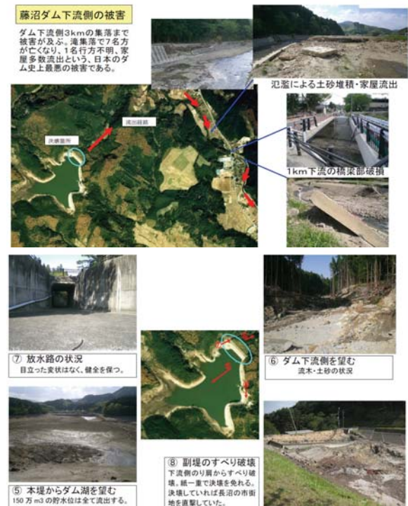
図2 藤沼ダム下流側等の被害状況
