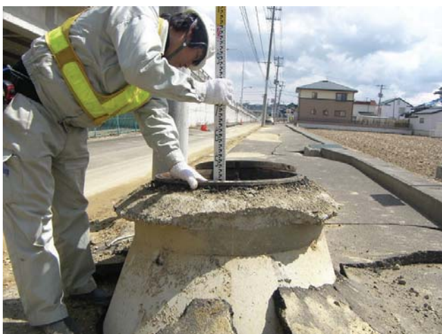
写真1 災害査定設計へ向けた下水道管路の調査
