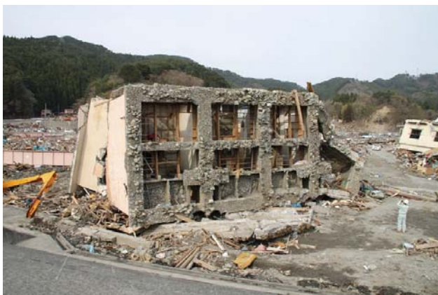
写真2 被害調査の様子 岩手県大槌町にて
