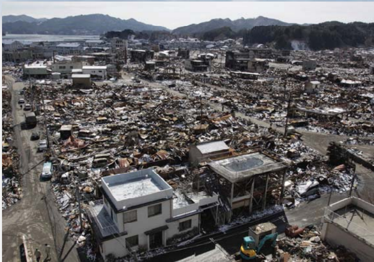
被災直後（山田町中心部）
