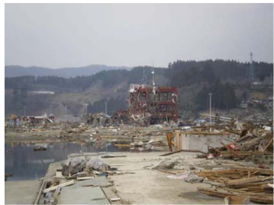
写真1 南三陸町の津波被災状況 —遠景の建物は町の災害対策本部—
