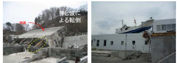
写真2 防潮堤破壊と堤内の様子
