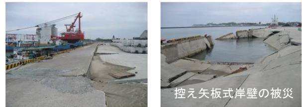
写真7 液状化による被害状況（相馬港）
