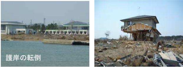
写真5 護岸の転倒と木造家屋破壊の状況
