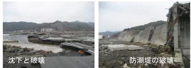
写真3 岸壁部と防潮堤の破壊状況
