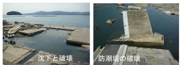
写真4 岸壁部と防潮堤の破壊状況
