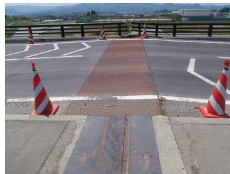
写真-11 伸縮装置部の応急復旧状況
