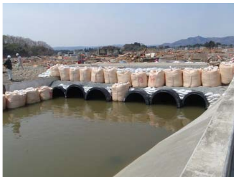
写真-4 釣師橋応急復旧状
