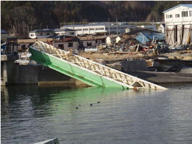
写真4 流失し天地逆になった宝来橋側道橋
