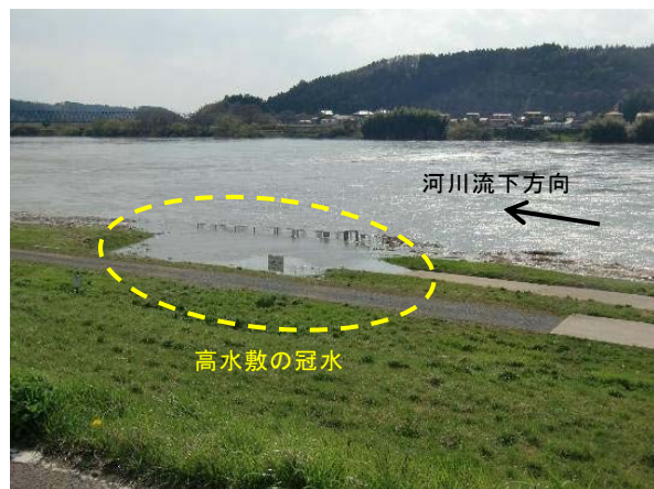
写真 12 高水敷の冠水状況
