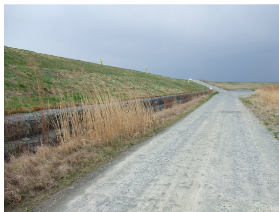
写真 13 鳴瀬川右岸 13.1k 地点の状況
