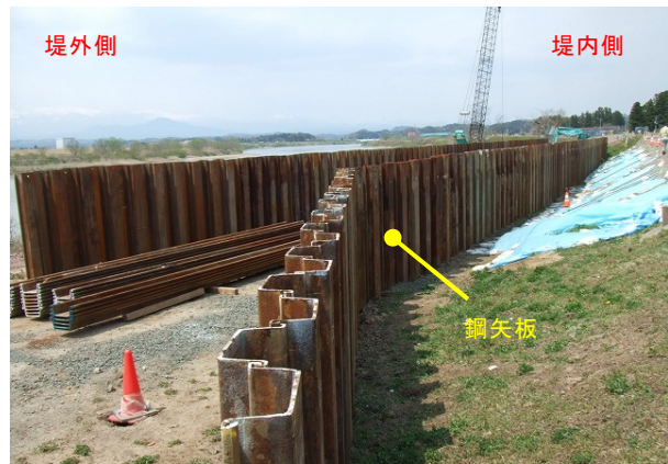
写真6 鋼矢板二重締切りによる仮堤
