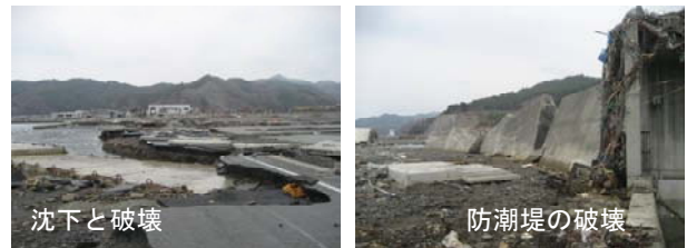
写真3 岸壁部と防潮堤の破壊状況
