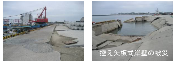
写真7 液状化による被害状況（相馬港）
