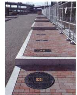
災害時用の仮設トイレは全部で64基。マンホールを開けて取っ手を引っ張るとトイレが出現する
