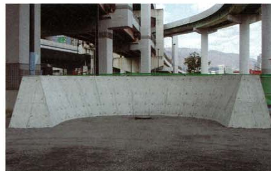
スケートボードなどで利用する重力式擁壁。建設中(写真:中川 美帆)
