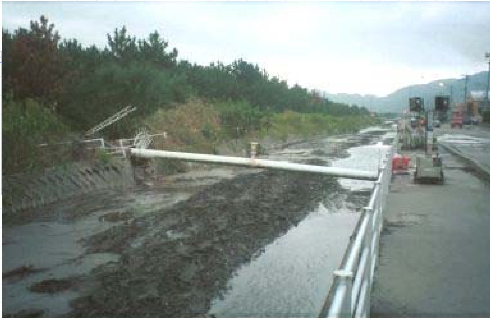
竹内団地 承水路に架かる水管橋
