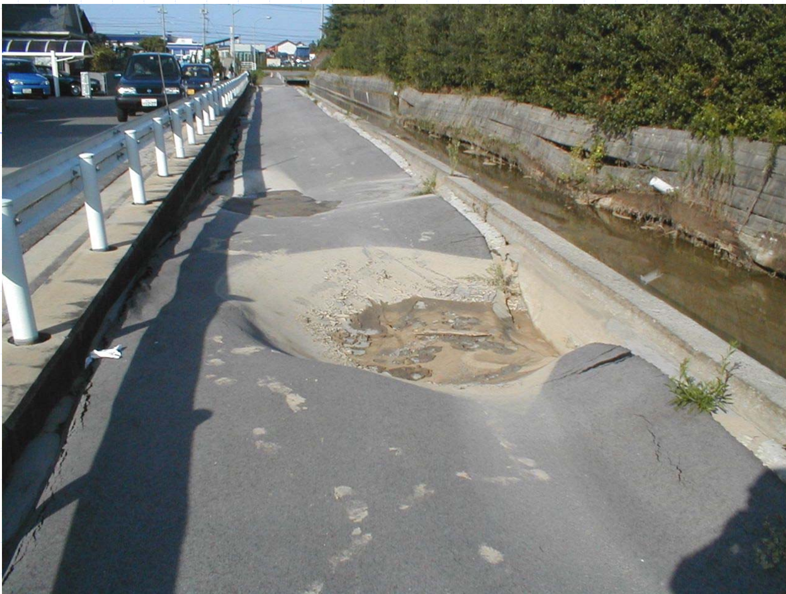
安倍彦名団地の被害状況（管理用道路の液状化による被害）
