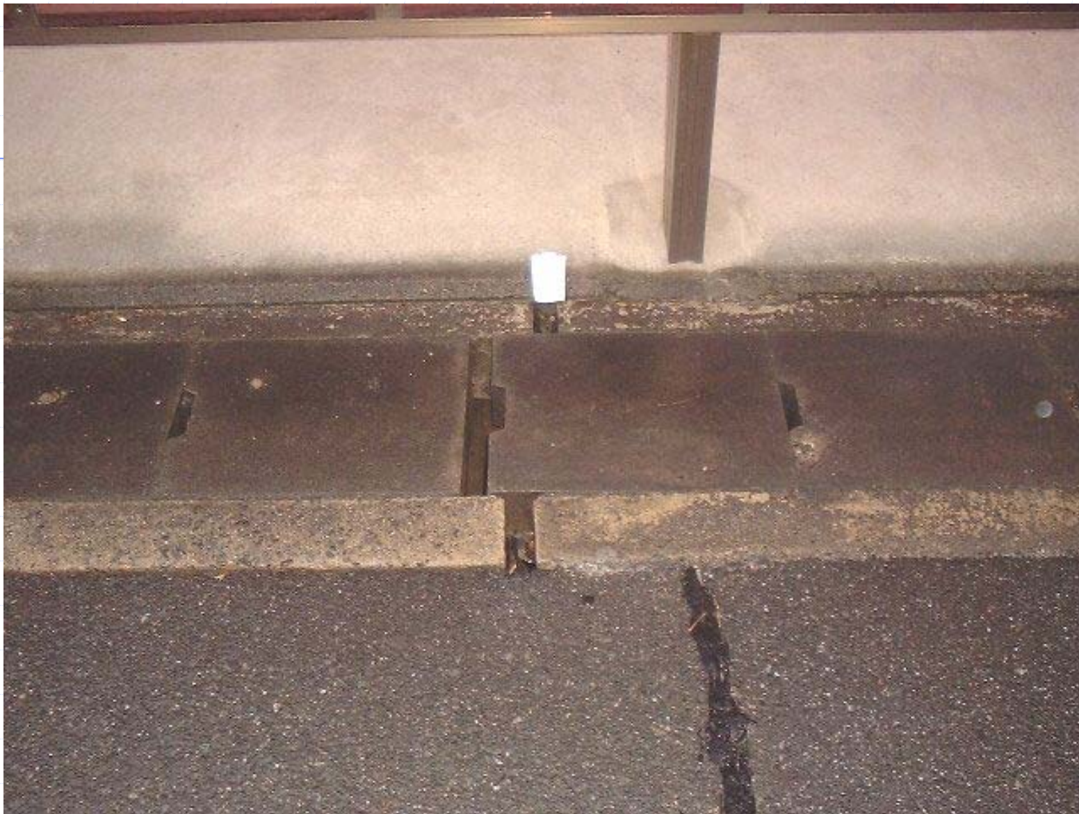
安倍彦名団地の被害状況（流動による地盤変位）
